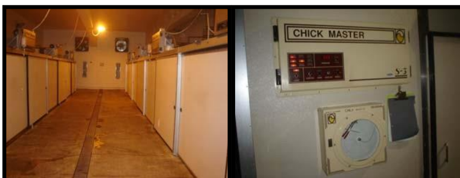
Sistema de control de temperatura
