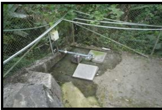
Pozo de captación de agua
