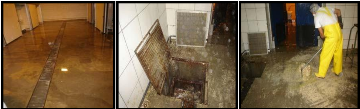
Canales para evacuación de aguas de proceso
