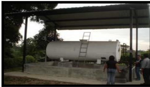
Tanque de almacenamiento de combustible
