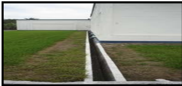
Cunetas para aguas lluvia
