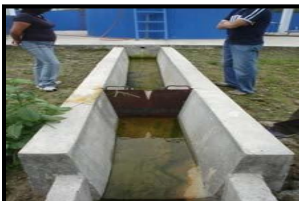
Punto de aforo de efluentes descargados
