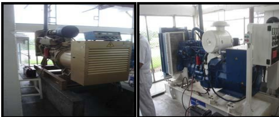
Generadores eléctricos de emergencia
