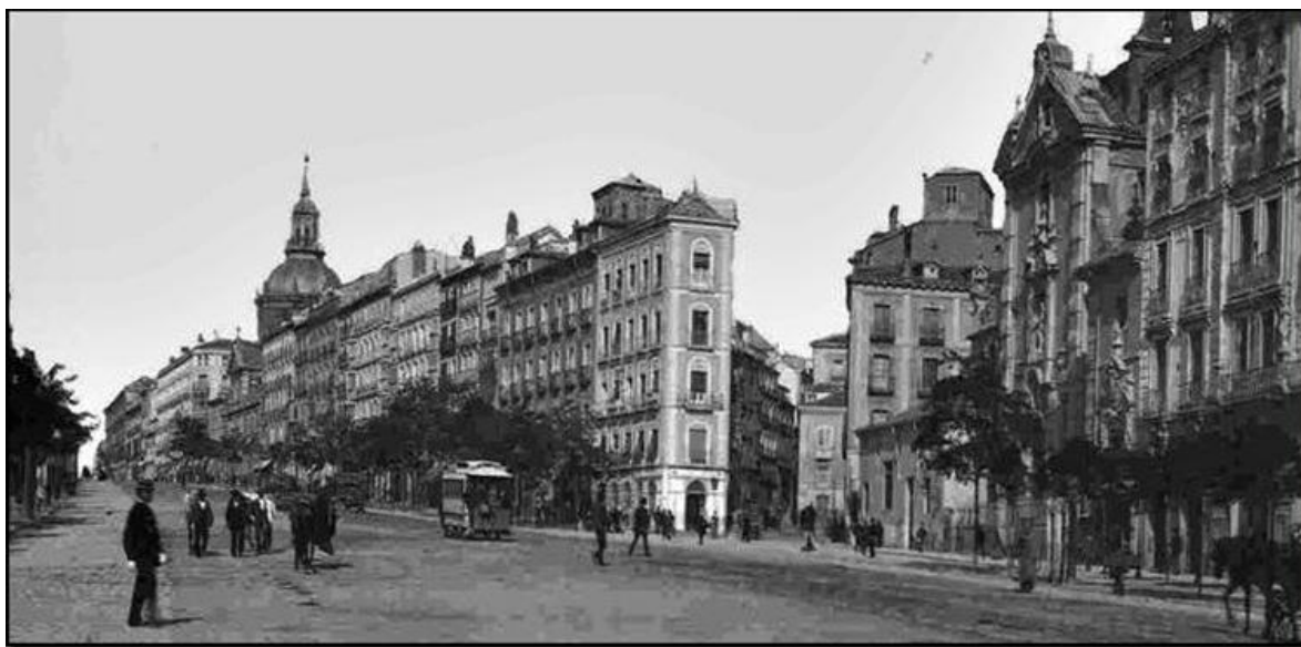
Imagen 18. Arquitectura en Madrid 1902
