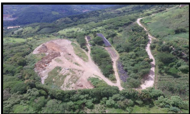
Figura 8: Botadero a cielo abierto del cantón Piñas
