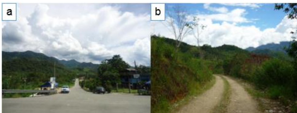
Figura 10 a) Vía de acceso a la Parroquia Timbara b) Vía Timbara - Buenaventura - San Marcos - Marín Ujukam - La Pituca Elaborado por: El autor
