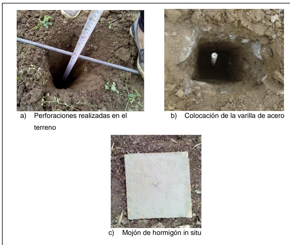
Figura 15. Construcción de la segunda marca
