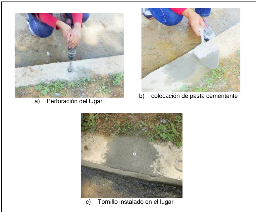
Figura 14. Instalación de la primera marca
