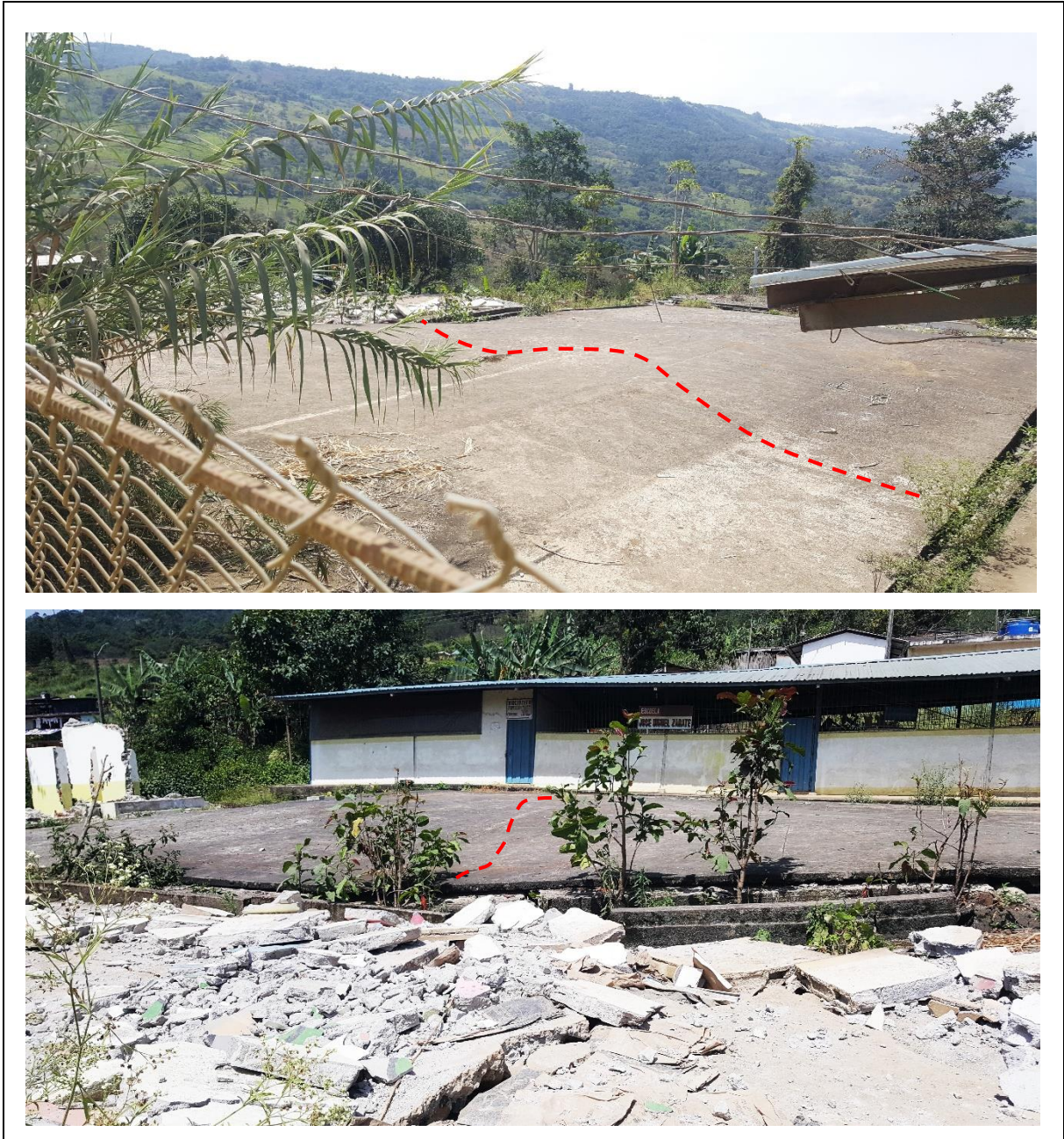
Figura 20. Daños ocasionados en la Escuela José Miguel Zárate Elaboración: La autora.
