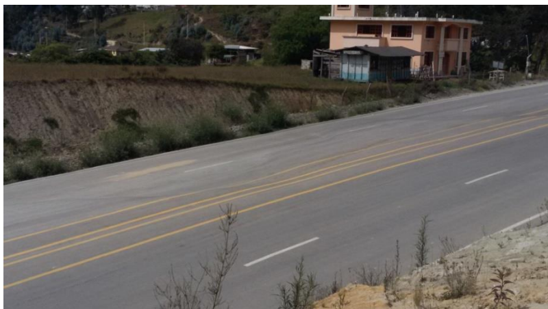
Figura 71. Hundimientos en vía que limita la zona de estudio. Fuente: Elaboración Propia.
