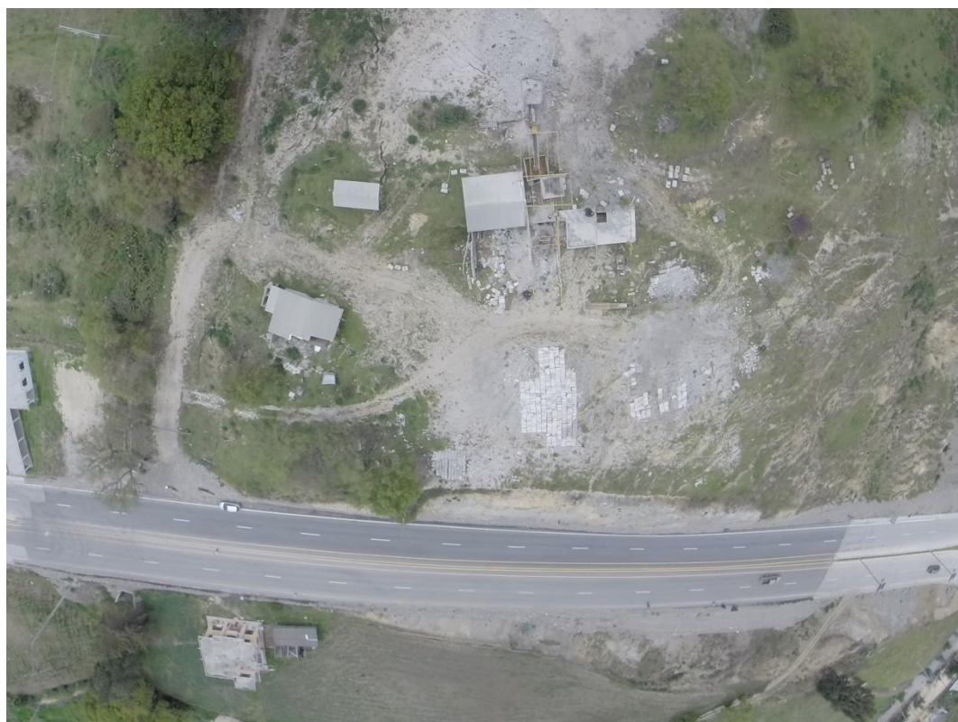
Figura 21. Reconocimiento de la zona de estudio con dron. Fuente: Elaboración Propia.
