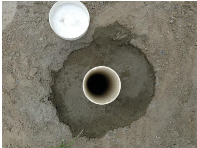
Figura 12. Tubos de acceso Fuente: Elaboración Propia.
