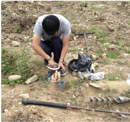
Figura 26. Instalación de tubos de acceso. Fuente: Elaboración Propia.
