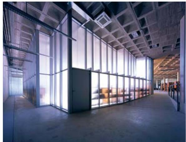
Figura 110. Pasillo interno. Paredes divisorias de policarbonato que consiguen dotar de iluminación a este espacio cerrado.
