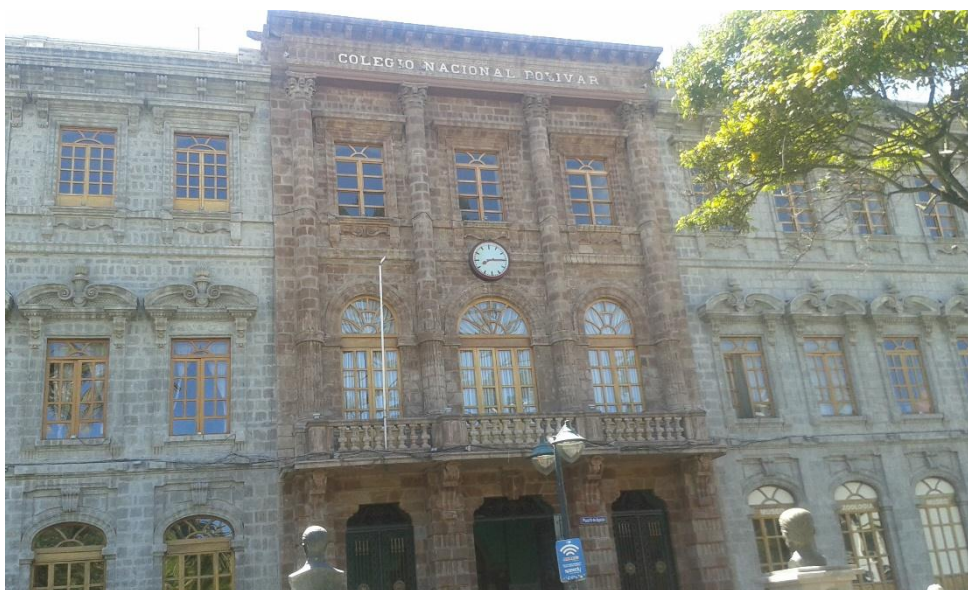
Fotografía 2: Exteriores de la Unidad Educativa Bolívar
