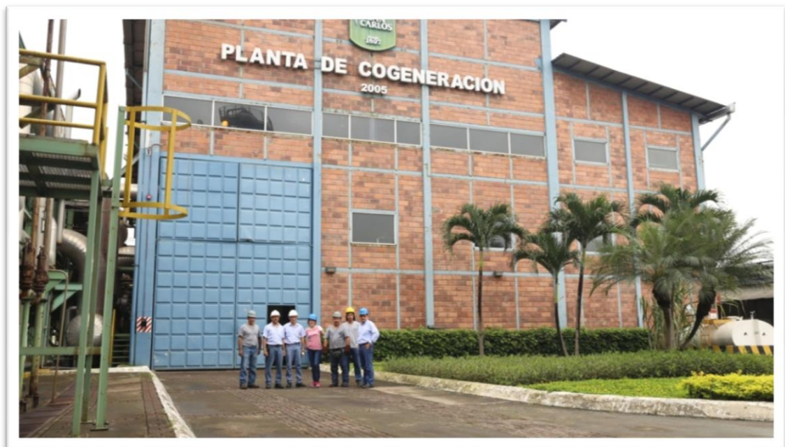
Figura 12. Ingenio San Carlos .Planta de cogeneración de Energía
