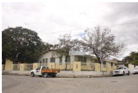
Fotografía N° 5. Subcentro de Salud Fuente y Elaboración: Kruscaya Ochoa, 2016.
