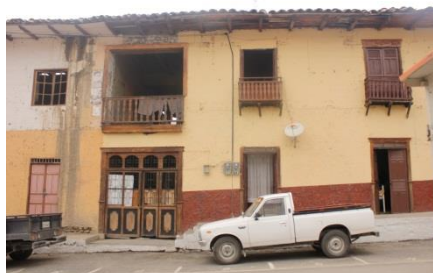
Fotografía N° 6. Vivienda tipo de Malacatos Fuente y Elaboración: Kruscaya Ochoa, 2016.
