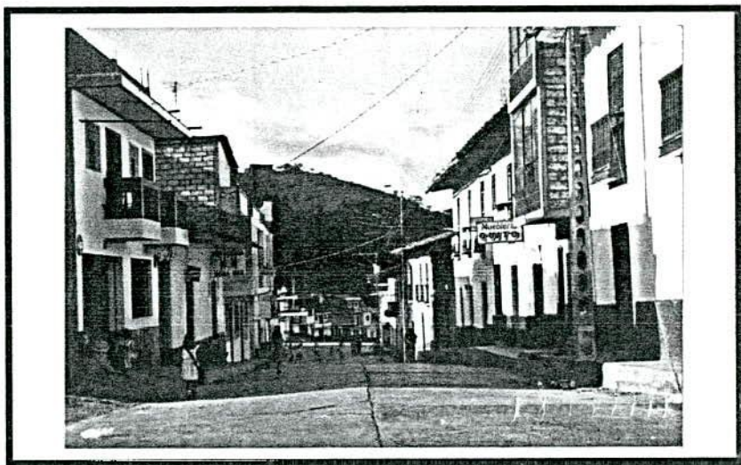
CALLE DOMINGO CELI: SE OBSERVAN ELEMENTOS DE HORMIGON ARMADO QUE DISTORSIONAN EL CONJUNTO
