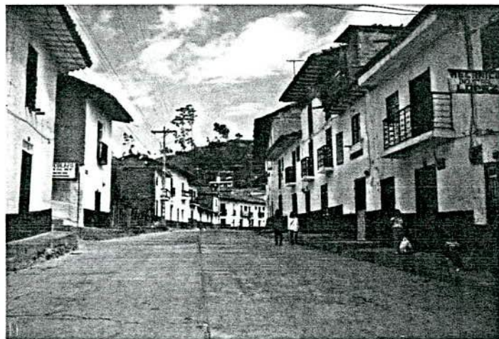
TRAMO DESDE EL CUAL SE ACCEDE AL SHIRICULAPO. EN LA PARTE DERECHA SE OBSERVA LA INCLUSION DE BALCONES DE H. ARMADO
