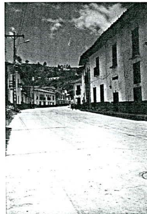
TRAMO CON PREDOMINIO DE VIVIENDAS EN DOS PLANTAS
