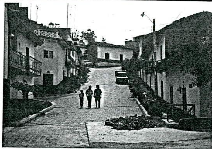
VIA ADOQUINADA (PROLONGACION DE LA CALLE LAURO GUERRERO)
