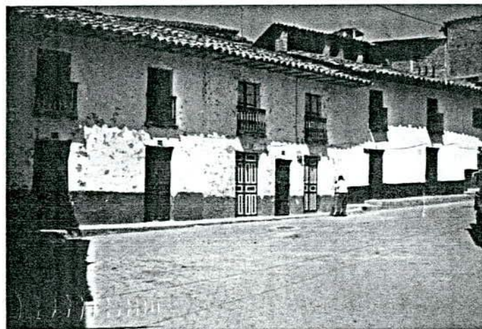
TRAMO DE LA CALLE LAURO GUERRERO AL INTERSECCION CON LA CALLE BOLIVAR
