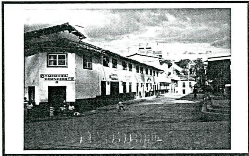
CALLE ADRIANO VALAREZO: TRAMO QUE ALTERA TOTALMENTE LAS CARACTERISTICAS DEL CONJUNTO
