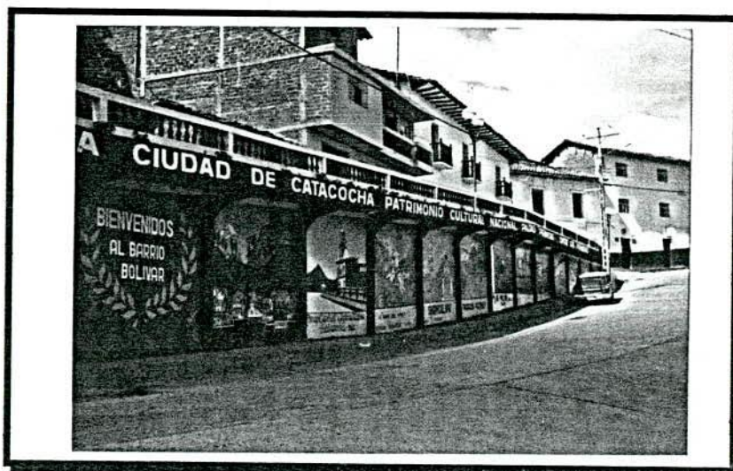
VIA PAVIMENTADA (CALLE BOLIVAR)
