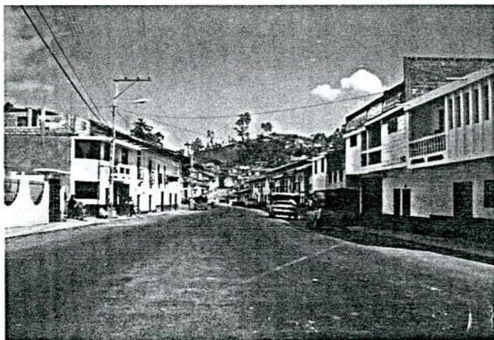
CALLE BOLIVAR: LUGAR DE ORIGEN DEL CONJUNTO URBANO (FRENTE AL CEMENTERIO)
