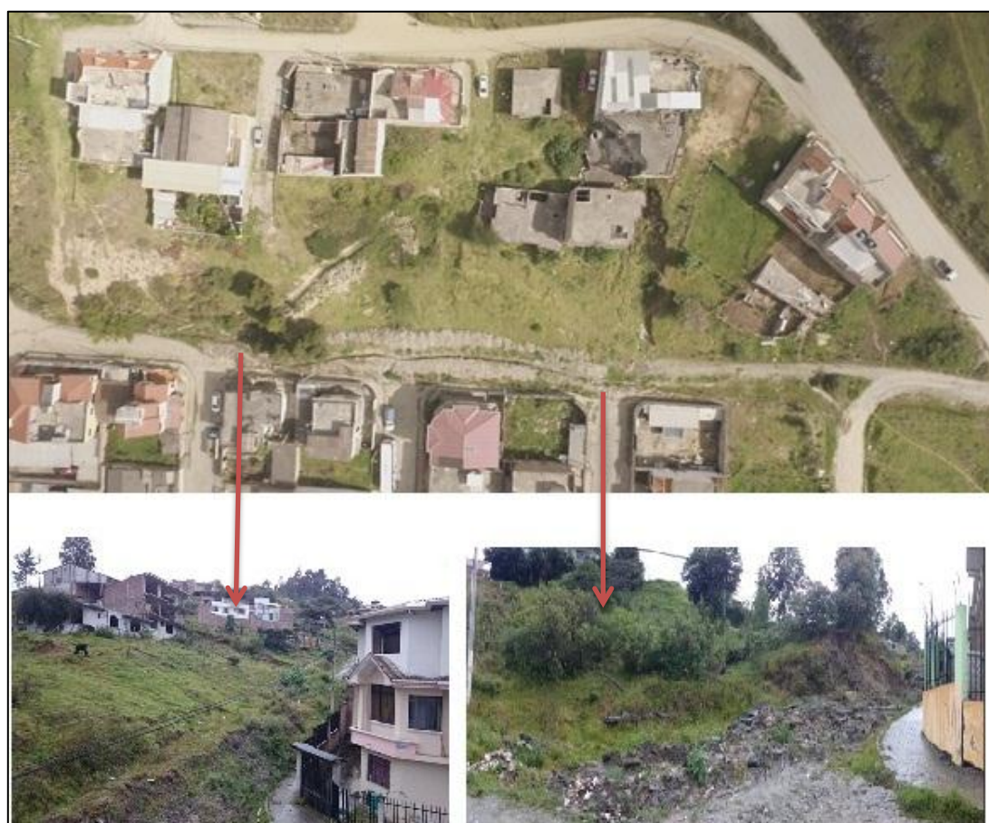
Figura 26. Imagen proyectada del pie del deslizamiento bloqueando la vía de acceso.
