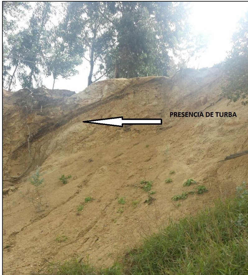
Figura 15. Presencia de turba en lutitas arcillosas.
