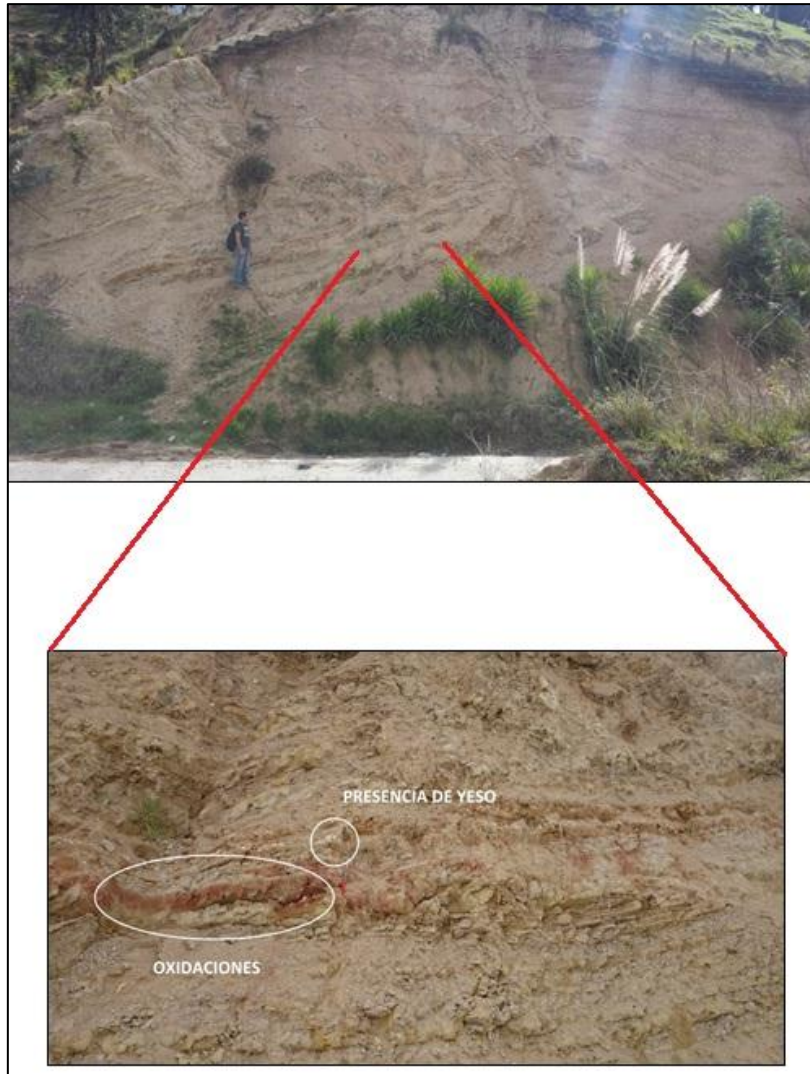
Figura 16. Oxidaciones y yeso en lutitas arcillosas.
