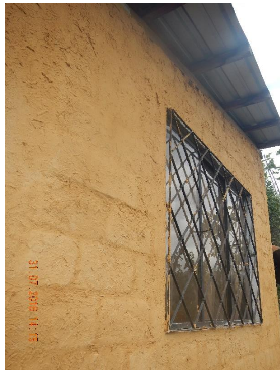
Imagen 83: Revoque aplicado en mampostería de ladrillo semana 3 Fuente: Autor
