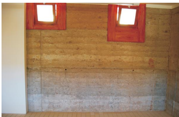
Imagen 4: Muro de tierra apisonada poroso Fuente: Informes de la construcción Vol. 63, 523, 143-152,
