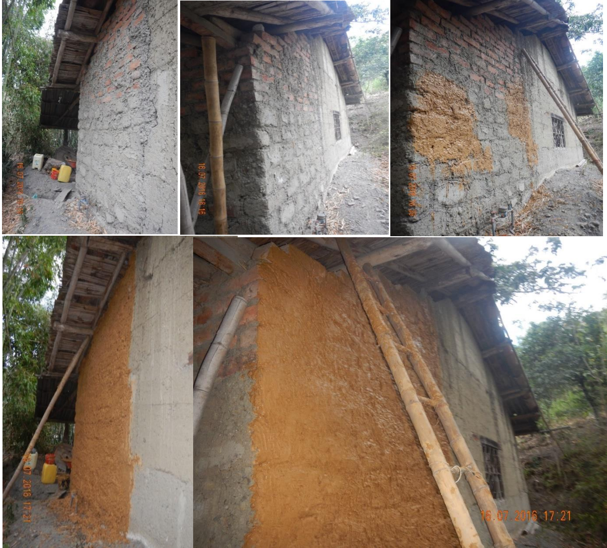
Imagen 80: Revoque aplicado en mampostería de ladrillo y adobe.
