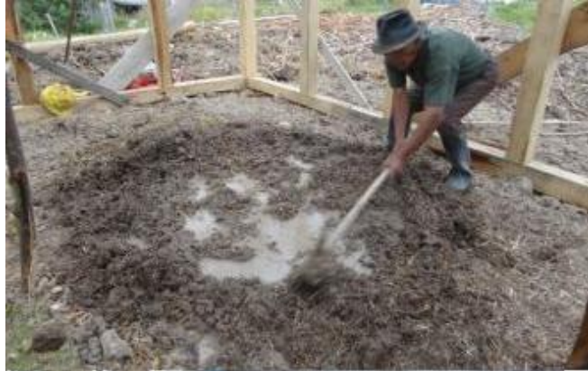
Imagen 28: Elaboración de barro in situ Fuente: (Vacacela, 2016)
