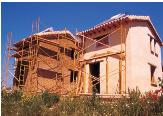
Imagen 23: Revoco de cal en muros de adobe y tapia Fuente: (Castilla F. J., 2011)
