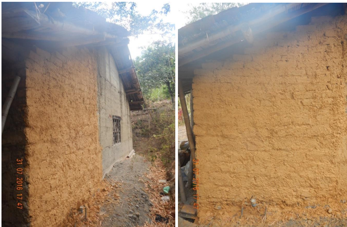
Imagen 84: Revoque aplicado en mampostería de ladrillo y adobe. Semana 3 Fuente: Autor
