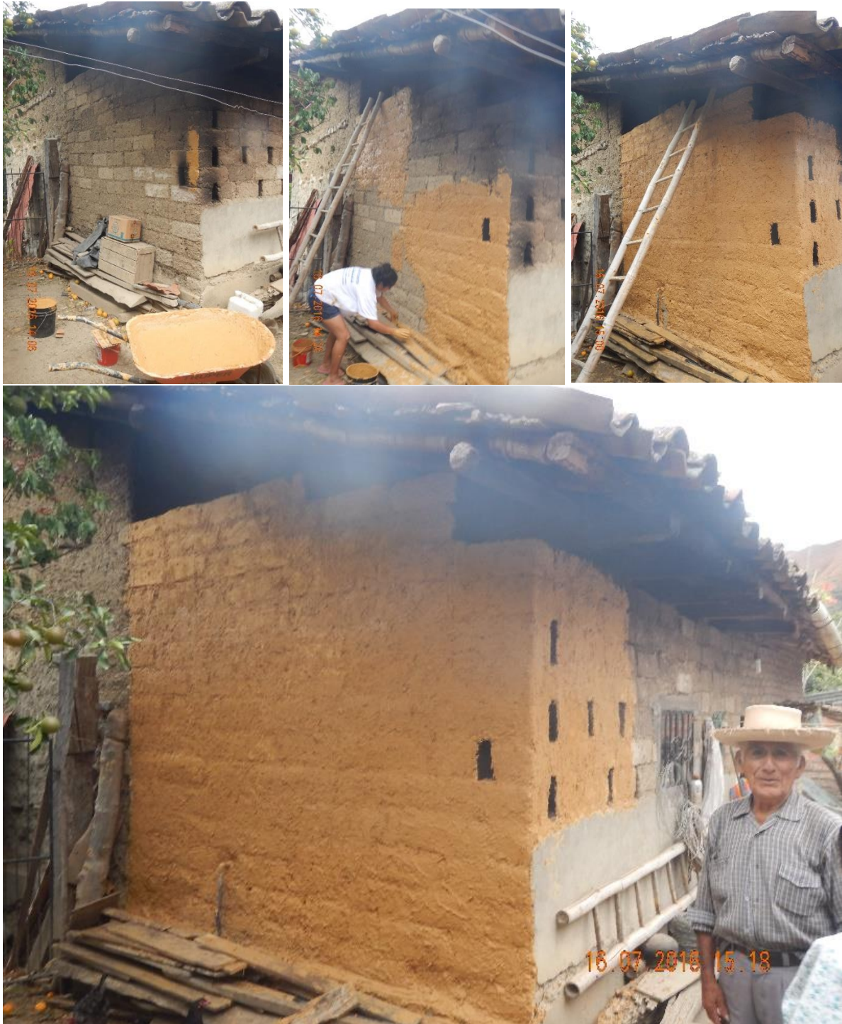
Imagen 78: Aplicación de revoque vivienda 1 Fuente: Autor
