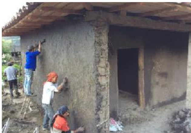
Imagen 29: Revoque de tierra en paredes Fuente: (Vacacela, 2016)
