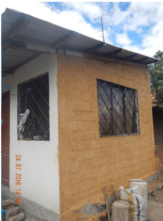
Imagen 83: Revoque aplicado en mampostería de ladrillo semana 3 Fuente: Autor
