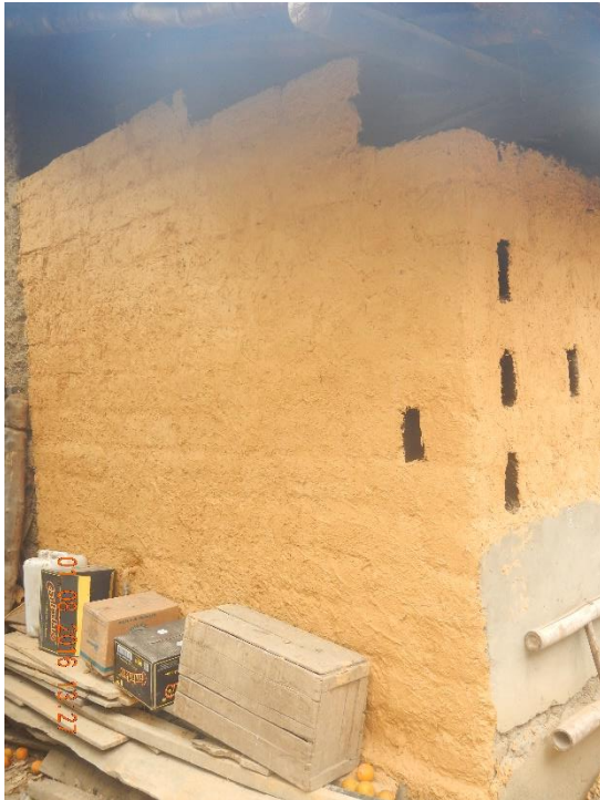
Imagen 82: Revoque aplicado en adobe. Fuente: Autor
