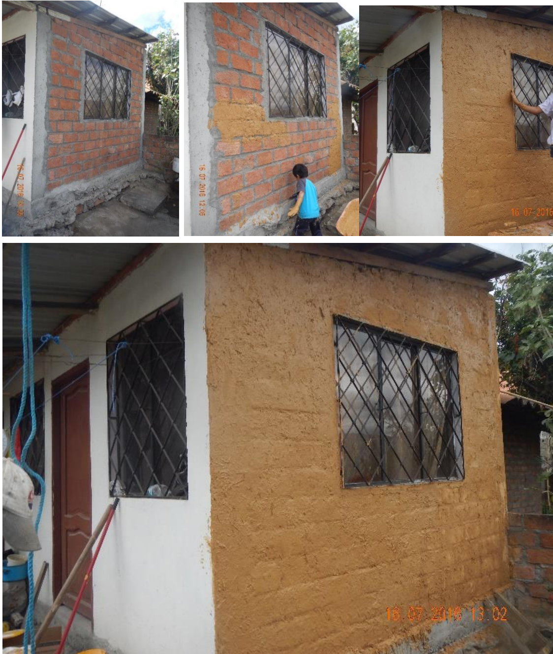
Imagen 79: Revoque aplicado en mampostería de ladrillo Fuente: Autor
