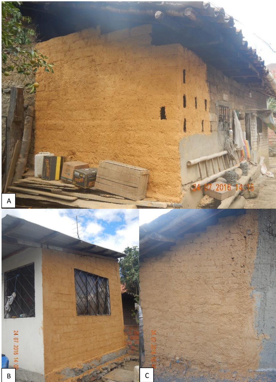
Imagen 81: Revoque aplicado en adobe (A) , mampostería de ladrillo (B) , adobe y mampostería de ladrillo (C)
