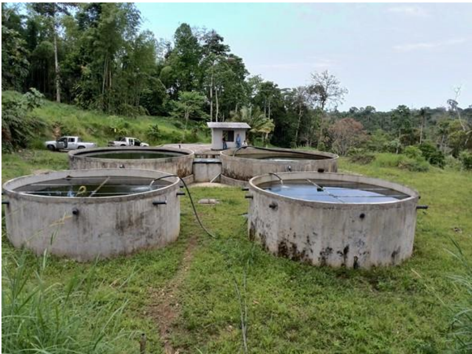
Figura16: Tanques de almacenamiento, tratamiento y distribución. Fuente: Cordova, A. (2016).
