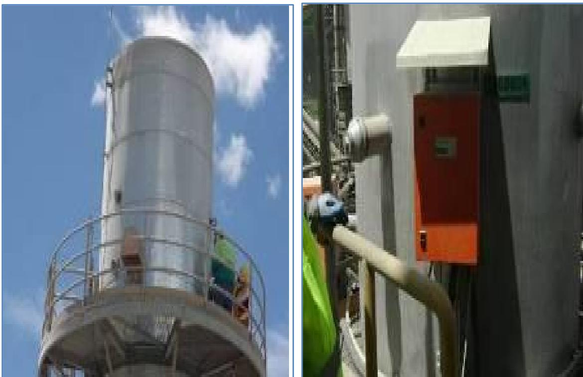
Figura 9: Puertos para monitoreo y sensores de controladores de emisiones gaseosas en chimeneas de los hornos.
