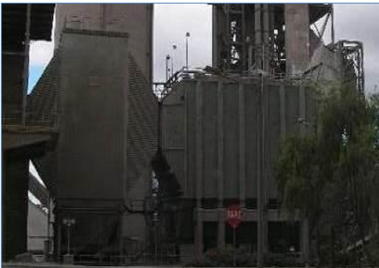
Figura 2: Filtros electrostáticos (Electrofiltros) para la recuperación de partículas sólidas.
