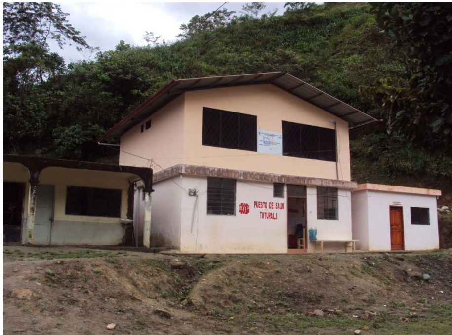
Vista exterior del Puesto de Salud Tutupali
