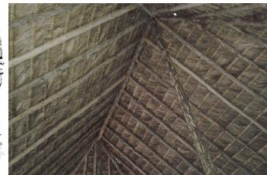
Figura 3.45 Cubierta comunidad Misahualli Fuente: El autor
