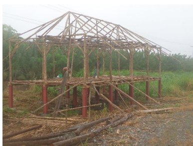
Figura 4.89 Construcción adaptación de la vivienda shuar elevada
