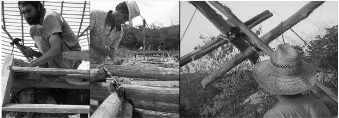
Foto N° 4-5-6. Armado de la estructura y componentes
