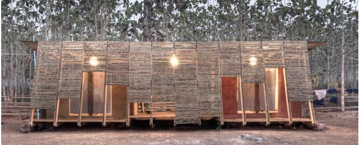
Foto N° 34. Safe Haven Bathhouse
