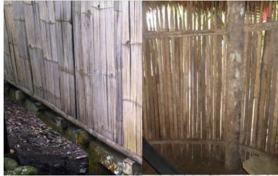
Figura 1.33 Paredes ranuradas viviendas shuar. Fuente: El autor
