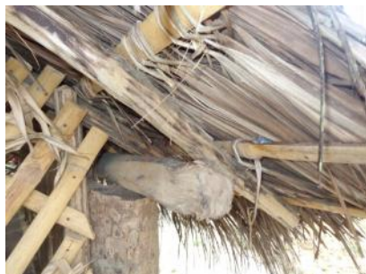
Figura 4.69 Sistema constructivo vivienda
