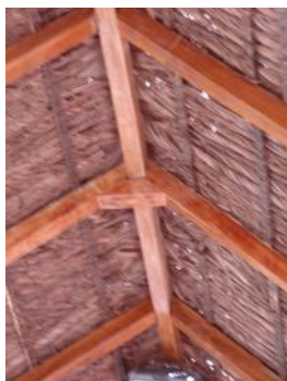
Figura 4.77 Sistema de ensamble en madera_Adaptación de la tipología de la vivienda shuar en sitio turístico Fuente: El autor Ubicación: Zamora
