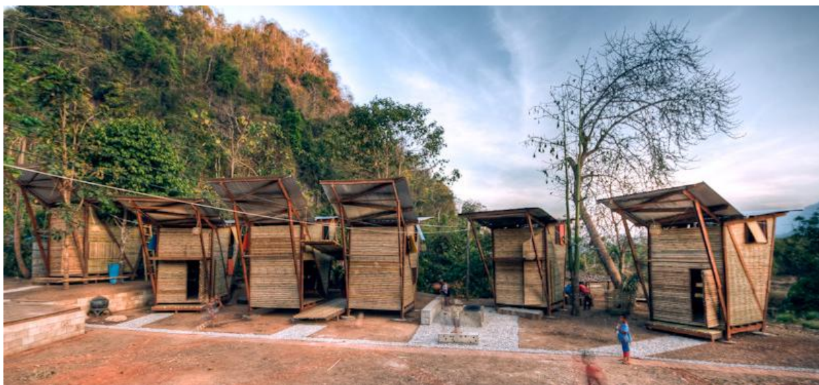
Foto N° 44. Soe Ker Tie House
