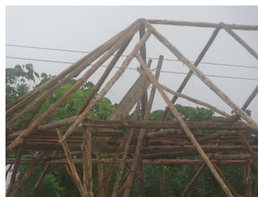
Figura 4.90 Construcción adaptación de la vivienda shuar elevada
