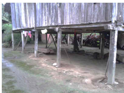
Figura 4.67 Vivienda elevadas sistema de protección_Paredes de chonta
