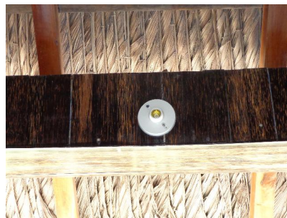
Figura 4.80 Sistema constructivo de chonta con hormigón_ Adaptación del sistema de iluminación a la pared de chonta Fuente: El autor Ubicación: Zamora
