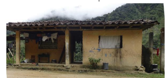
Figura 4.29 Vivienda de ladrillo. Fuente. El autor
