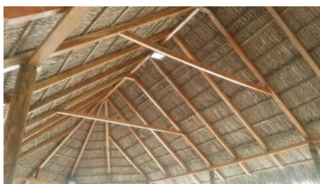
Figura 4.81 Sistema constructivo madera en sector turístico_ Cubierta de paja Fuente: El autor Ubicación: Provincia de Zamora{
