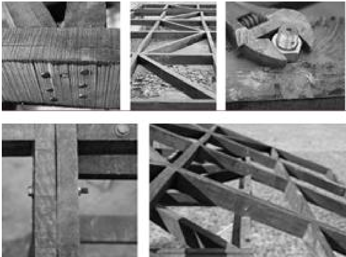
Foto N° 22-26. Armado de la estructura y componentes
