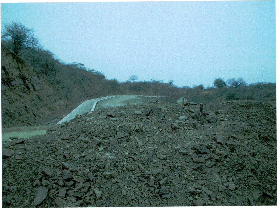
Foto No. 2: Material desalojado de excavación.
