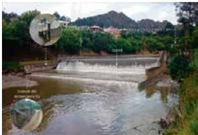
Un Desarenador; con elementos hidráulicos como: azud, canal lateral de emergencia y compuerta frontal de lavado de sedimentos. En este lugar por sus condiciones topográficas y de accesibilidad, es donde el Municipio preveía la explotación de áridos que luego serían utilizados por el Municipio de Loja.
