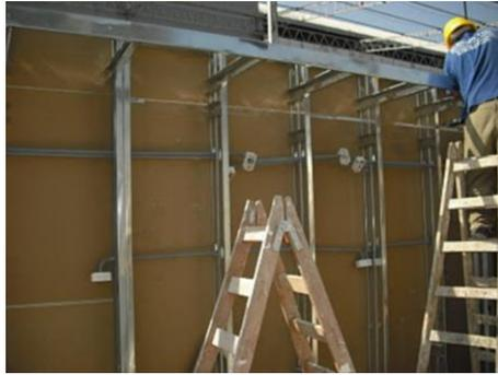
**Figura 17.** Estructura galvanizada
