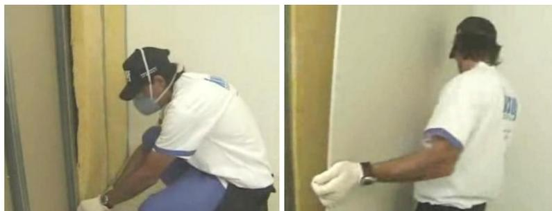
**Figura 19.** Colocación de fibra de vidrio
