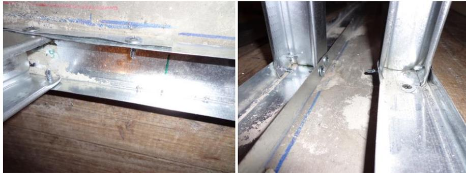
**Figura 49.** Tornillos punta de broca autoperforante
