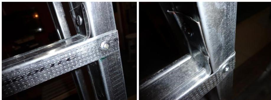
**Figura 50.** Fijación del tornillo
