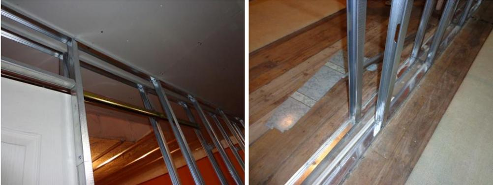
**Figura 47.** Estructura metálica track y stud
