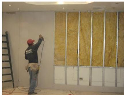
**Figura 18.** Colocación de placas drywall de yeso
