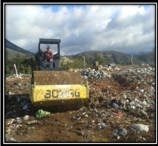
**Figura 11:** Rodillo encargado de realizar la compactación de los residuos con la tierra
