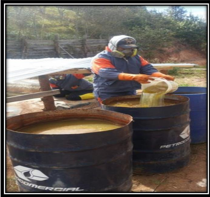
**Figura 13:** Lixiviados producidos por la descomposición de los residuos sólidos en el relleno sanitario.
