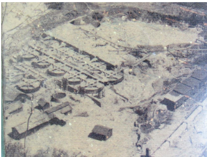
Figura 12. Construcción de la Primer parte del Campamento
