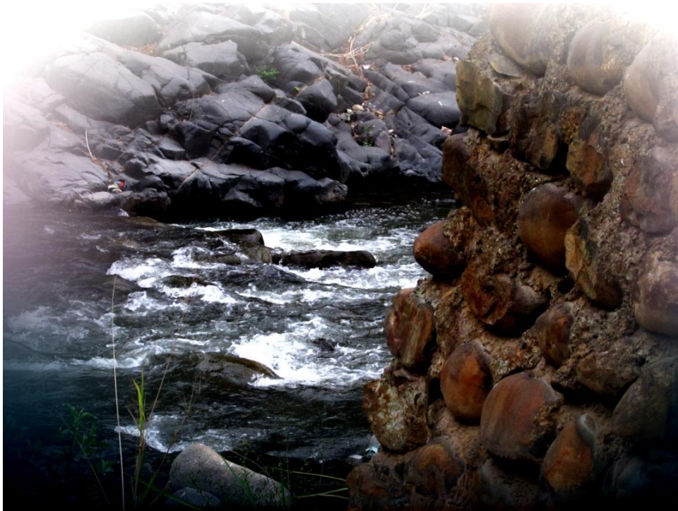
Ilustración 33. Muro de piedra Fuente: La autora.
