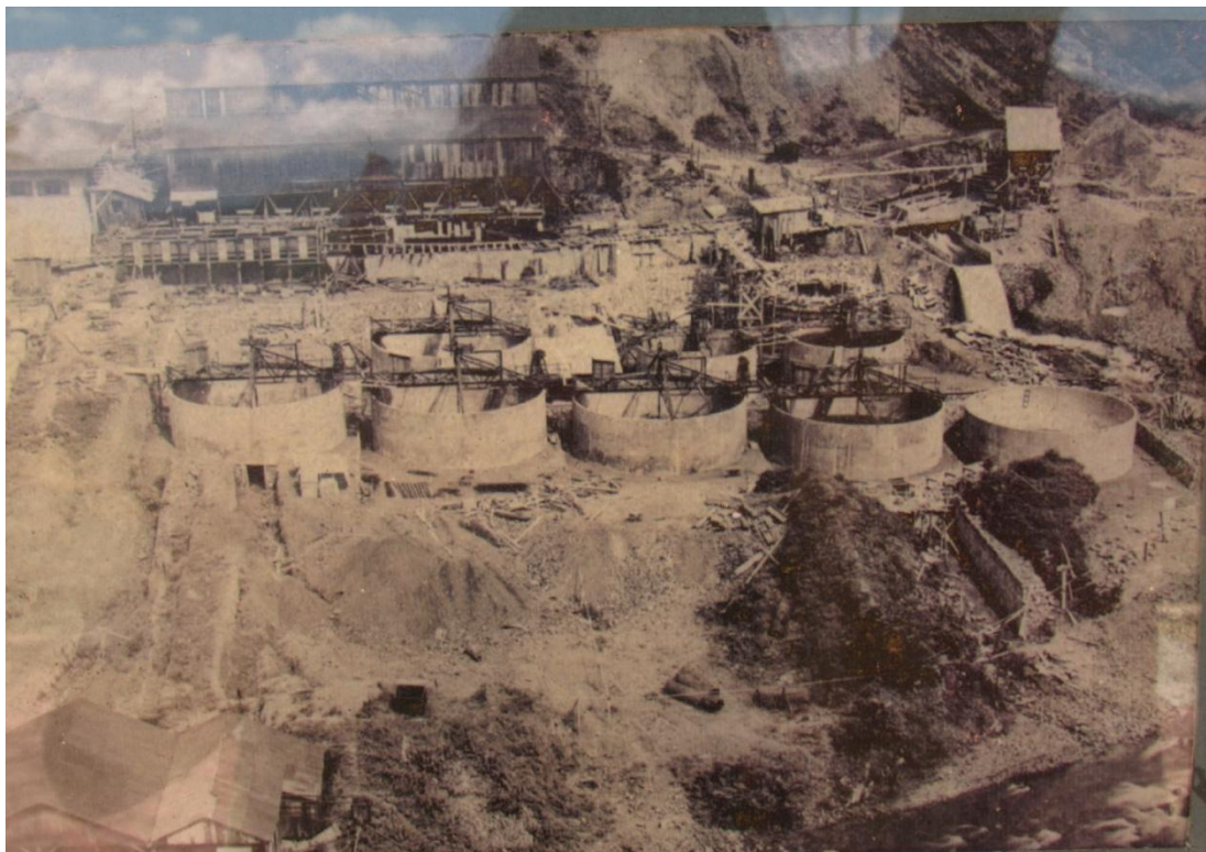
Figura 14. Avances en la construcción de los tanques
