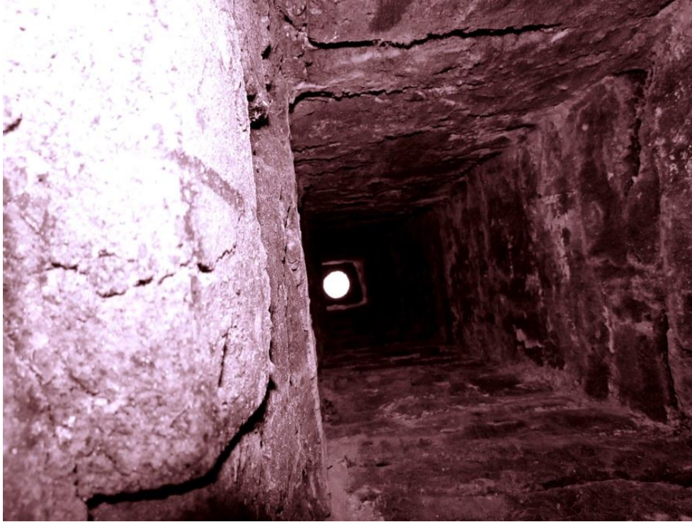
Ilustración 1. Interior de Chimenea
