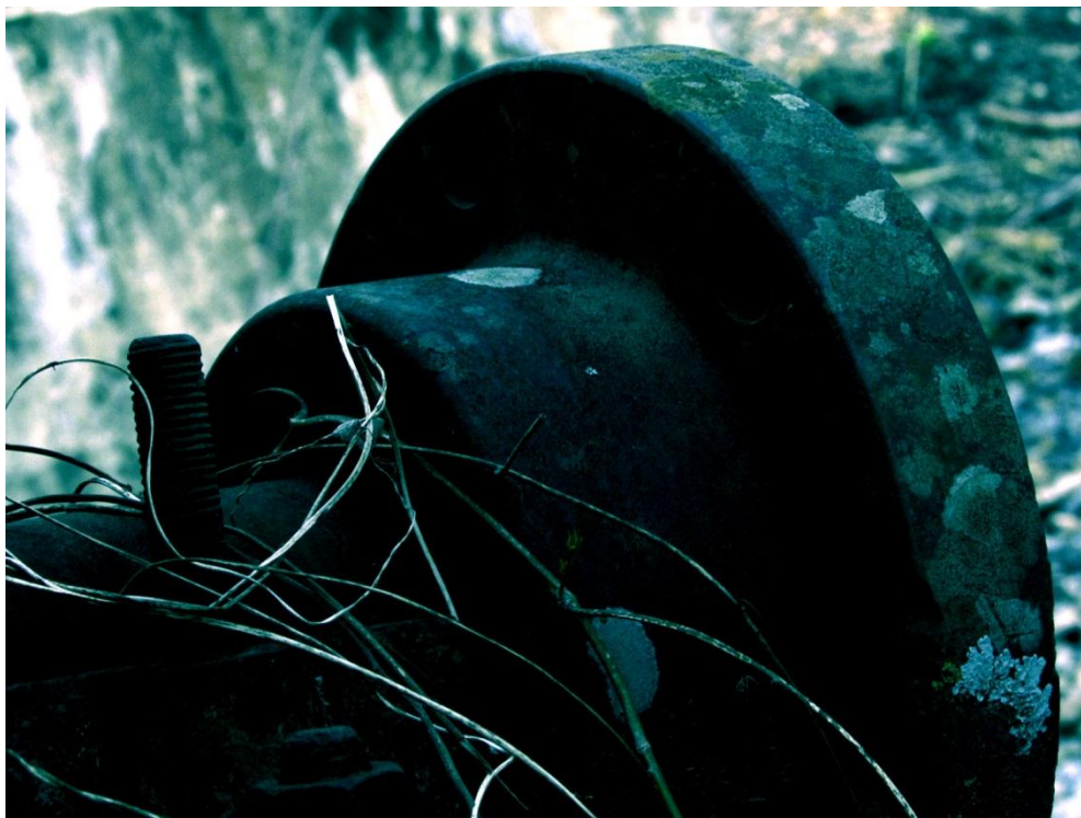
Ilustración 7. Detalle de estructura que sostiene al molino
