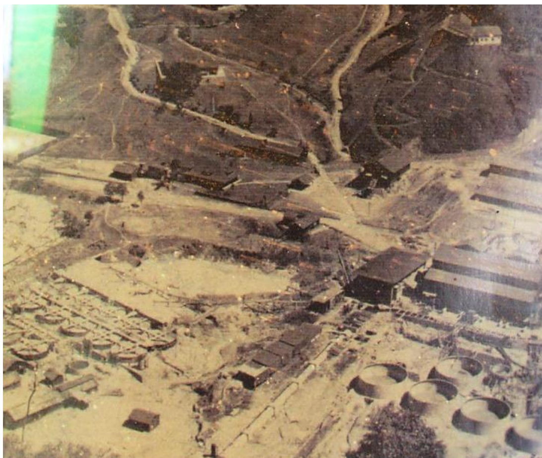
Figura 5. Construcción del Campamento Americano.
