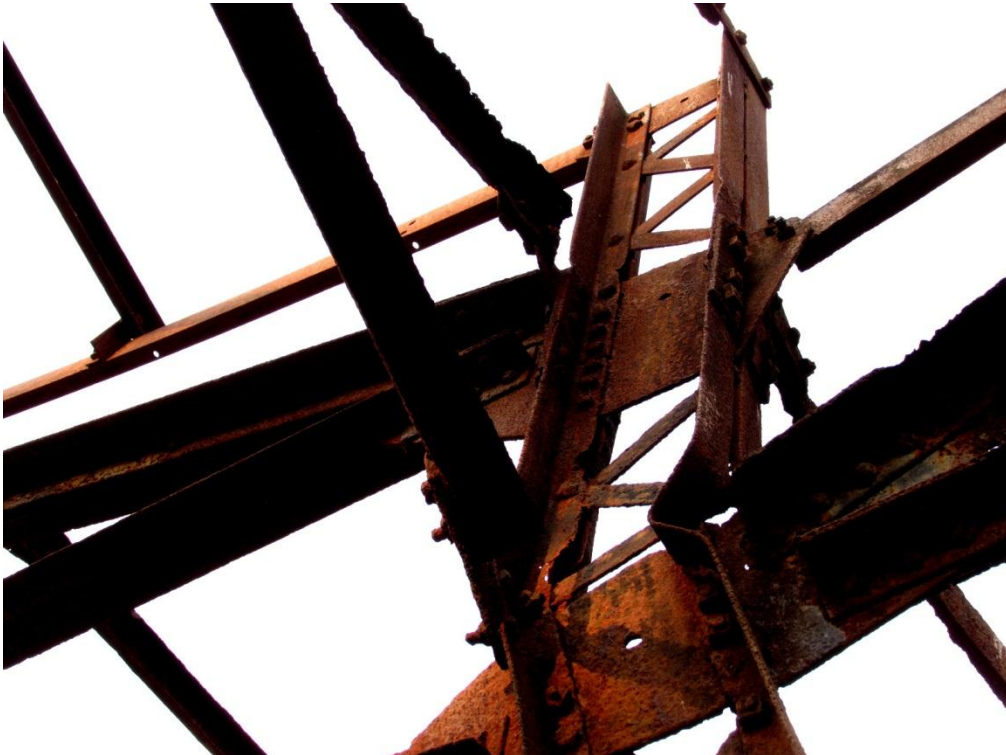
Ilustración 40. Estructura vertical del techo Fuente: La autora
