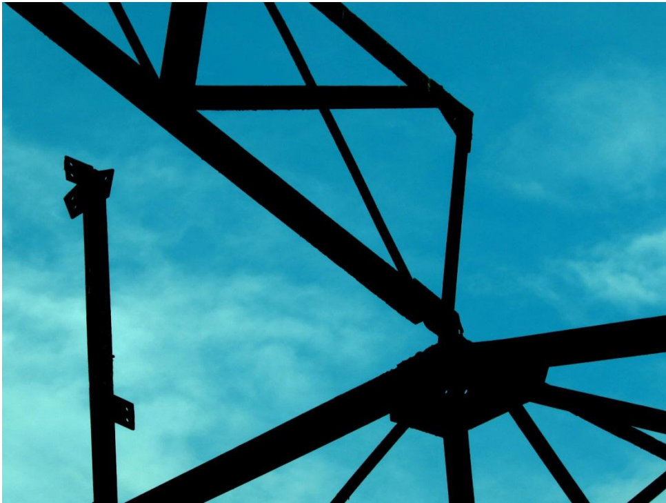
Ilustración 35. Parte de estructura del techo Fuente: La autora.
