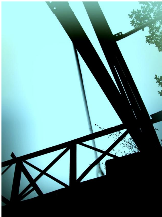
Ilustración 10. Detalle de una estructura
