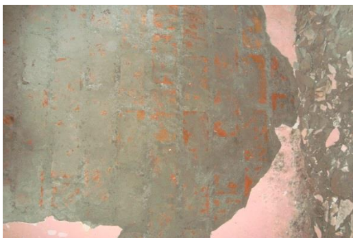
Extracción del mortero dañado
