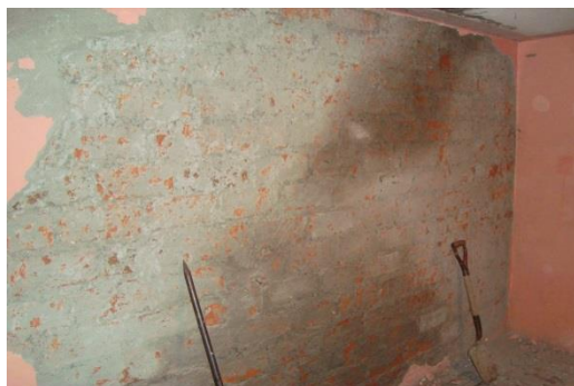
Secado y curado de la mampostería
