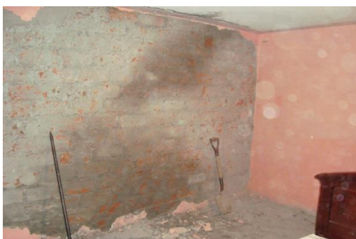
Extracción total del mortero
