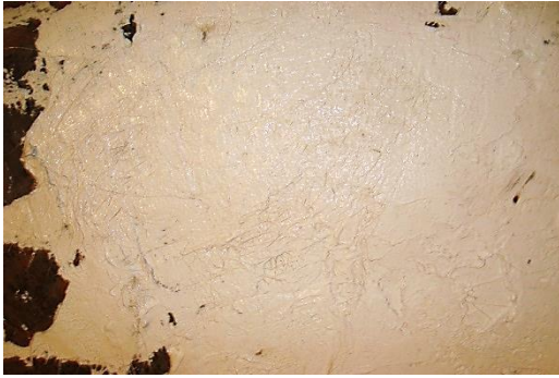
Aplicación en la mampostería
