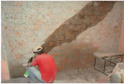
Colocación de impermeabilizante
