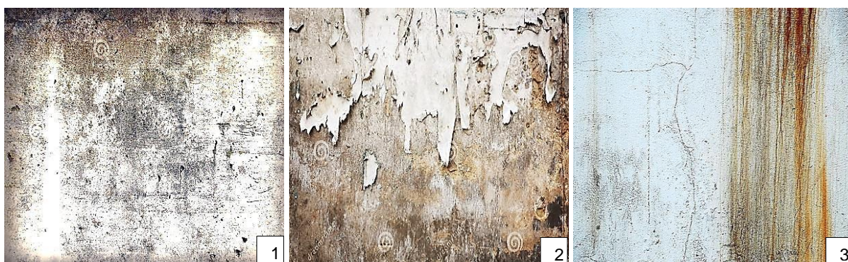
Figura 7: Lesión física, suciedad 1 – 3. Presencia de suciedad
