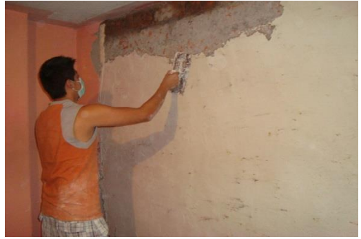
Aplicación con llana metálica
