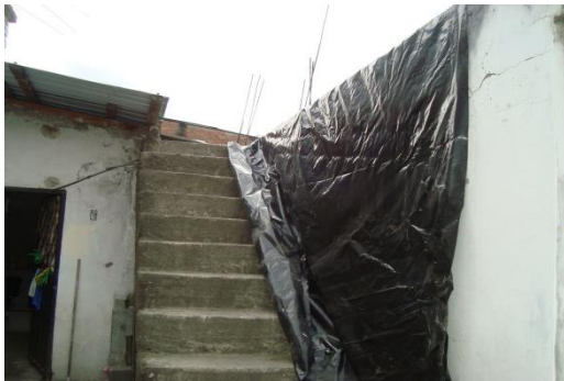
Curado exterior mampostería
