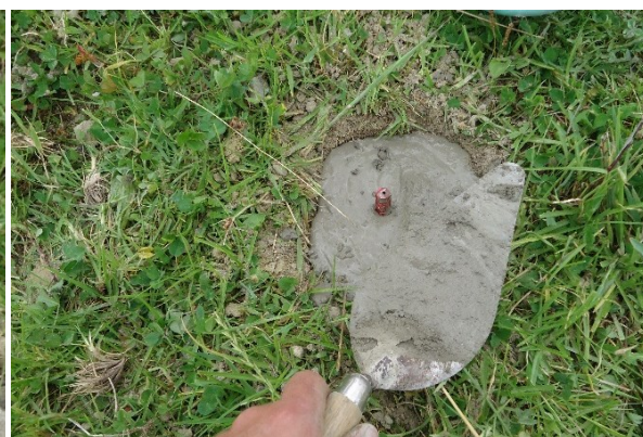
Figura 9: Procedimiento de la colocación de la varilla y el ajuste con hormigón Fuente y Elaboración: El Autor
