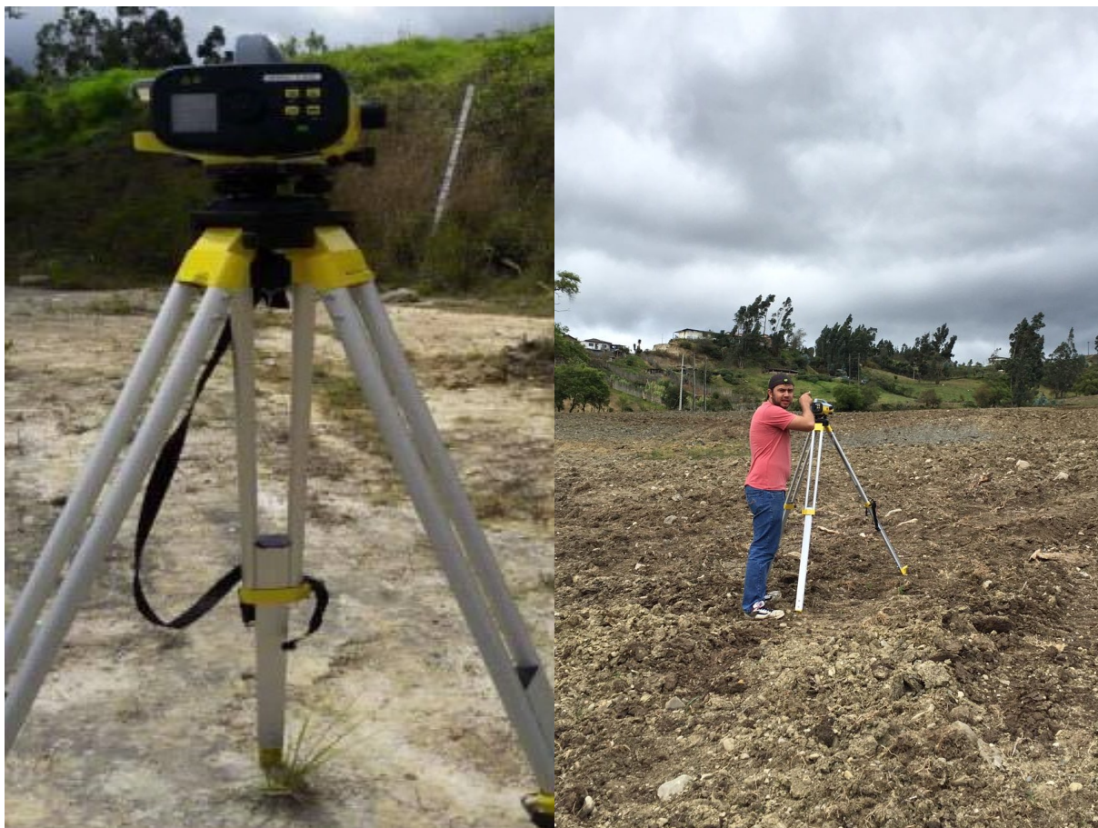
Figura 12: Procedimiento del levantamiento con el equipo Nivel Electrónico ZDL 700 Fuente y Elaboración: El Autor
