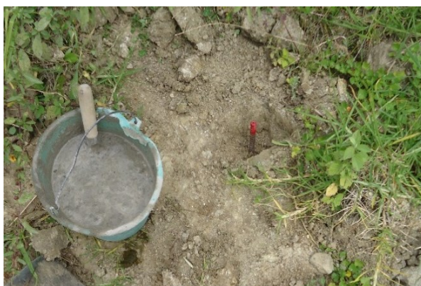
Figura 9: Procedimiento de la colocación de la varilla y el ajuste con hormigón Fuente y Elaboración: El Autor
