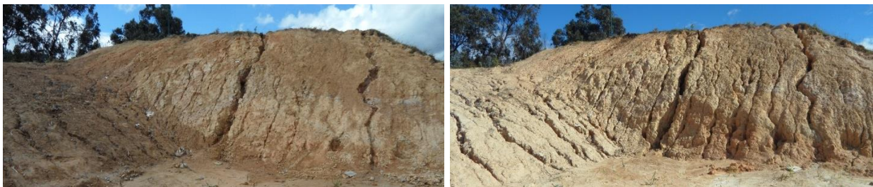
Figura 33: “Talud N.1” estado inicial (29-ago-2016) y estado final (17-ene-2017)
