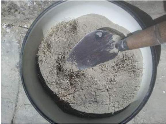
Ilustración 366. Mezcla manual entre árido fino y cemento e incorporación de la fibra a la mezcla.
