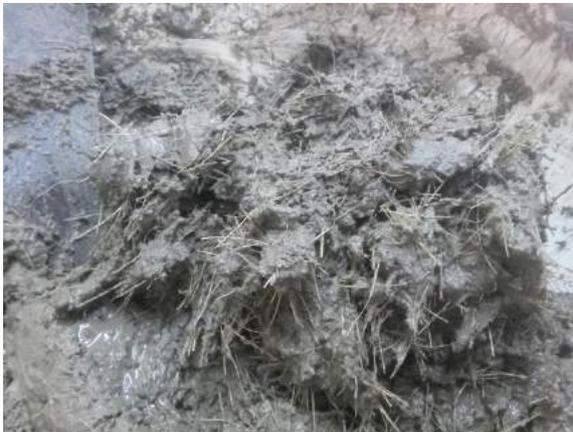
Ilustración 261. Agregado del agua + aditivo en la mezcla.
