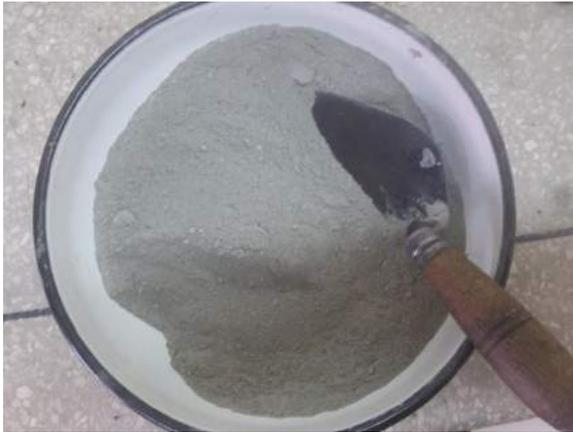
Ilustración 259. Mezcla manual entre cemento y árido fino.
