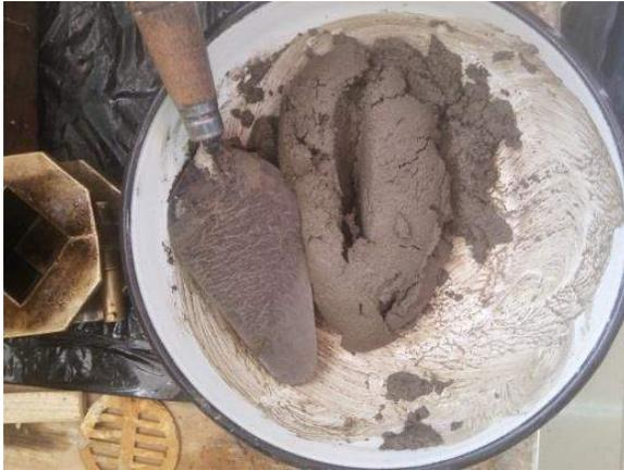
Ilustración 143. Mezcla homogénea ya con agua + aditivo.
