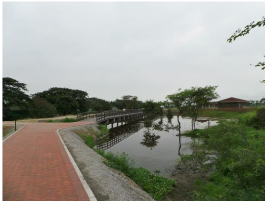
Imagen 13: Puente sobre el humedal Elaborado por: El autor
