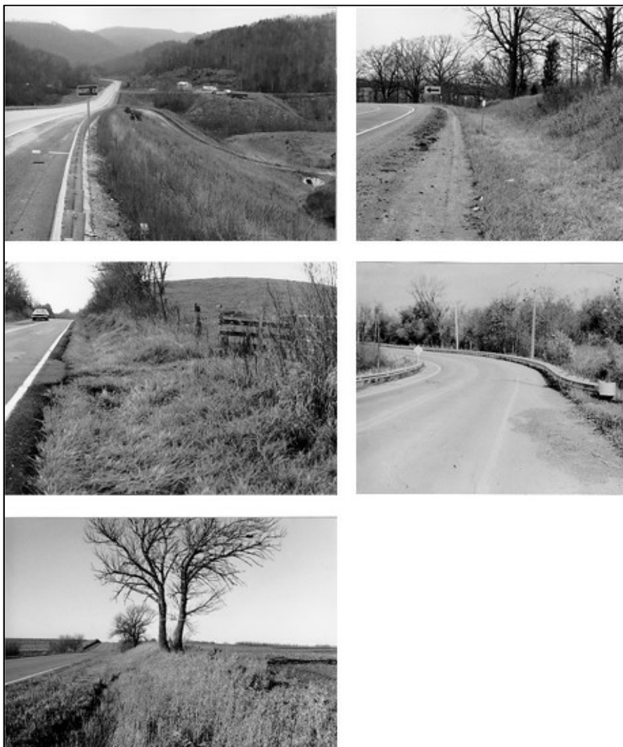
Figura 24. Fotos de 5 segmentos típicos de carretera con calificación de riesgo de carretera igual a 4 Fuente: IHSDM (2012) Elaborado por: Autora
