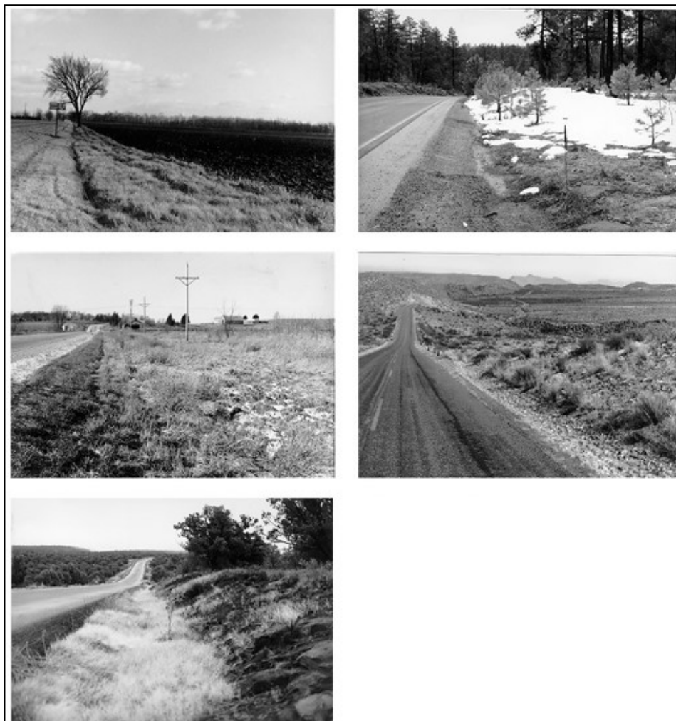
Figura 23. Fotos de 5 segmentos típicos de carreteras con calificación de riesgo en carretera igual a 3 Fuente: IHSDM (2012) Elaborado por: Autora
