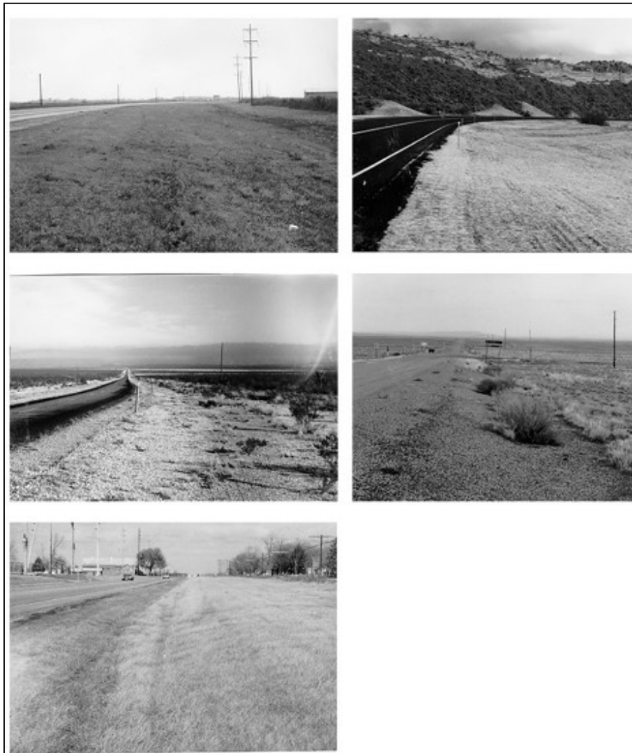
Figura 21. Fotos de 5 segmentos de carreteras típicas con calificación de riesgo en carretera igual a 1.
