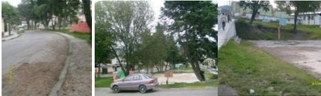
Mal estado de aceras y bordillos en algunos tramos son inexistentes, debido al uso inadecuado por parte de autos, además falta de barreras de protección en desniveles.
