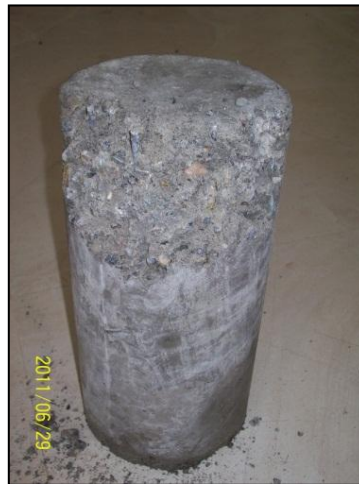
Figura 4.3.2_3. Desprendimiento del hormigón en elementos con recubrimiento apropiado Fuente: El Autor.
