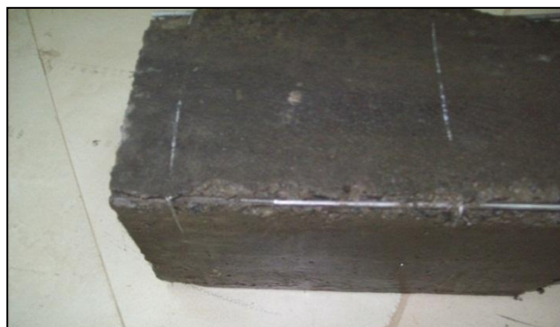
Figura 4.3.1_4. Deslizamiento de las barras en elementos sin recubrimientos Fuente: El Autor.
