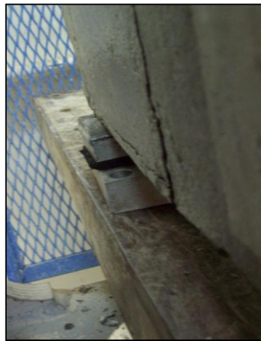
Figura 4.3.1_2. Viga con un centímetro de recubrimiento Fuente: El Autor
