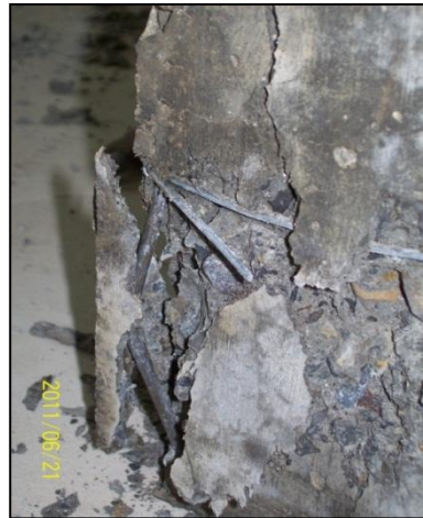
Figura 4.3.2_1. Pandeo de las barras longitudinales en elementos con recubrimiento insuficiente o nulo. Fuente: El Autor.
