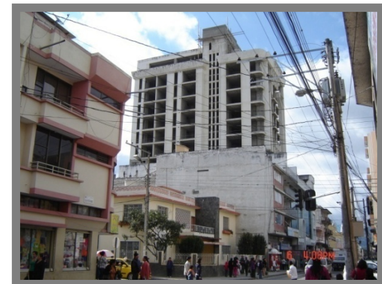
Foto 3.18 Edificación que altera el perfil urbano en el Centro Histórico Fuente: La autora
