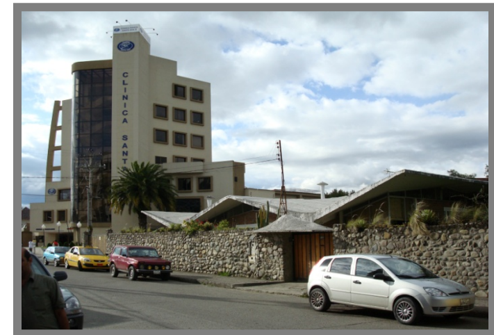
Foto 2.29 Incremento de Elevación de Altura en edificaciones del sector de El Ejido. Fuente: INPC (Dic. 2008)
