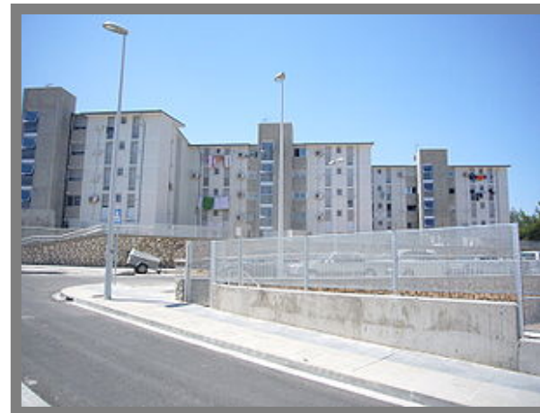
Foto 1.1: Rehabilitación de San Martín de Porres, Córdoba.
