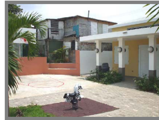
Foto 2.10 Las viviendas están en condiciones de deterioro físico Fuente: Tesis. El fenómeno de la gentrificación en la comunidad Alto del Cabro, Santurce. Puerto Rico.
