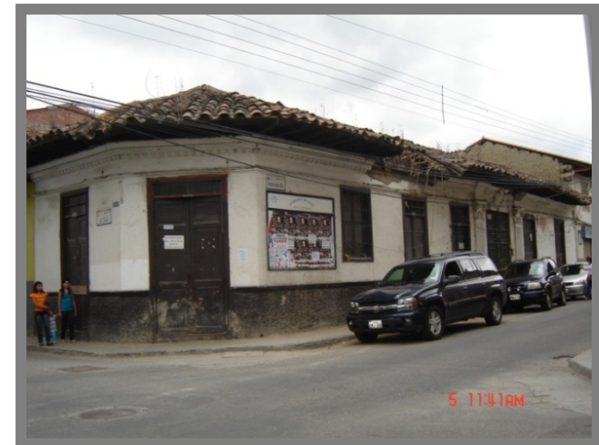
Foto 3.21 Deterioro de edificación tradicional Fuente: La autora Ubicación: Calle José Antonio Eguiguren y Sucre (esq. Norte este)
