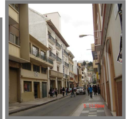
Foto 3.8 Edificación nueva Fuente: La autora
