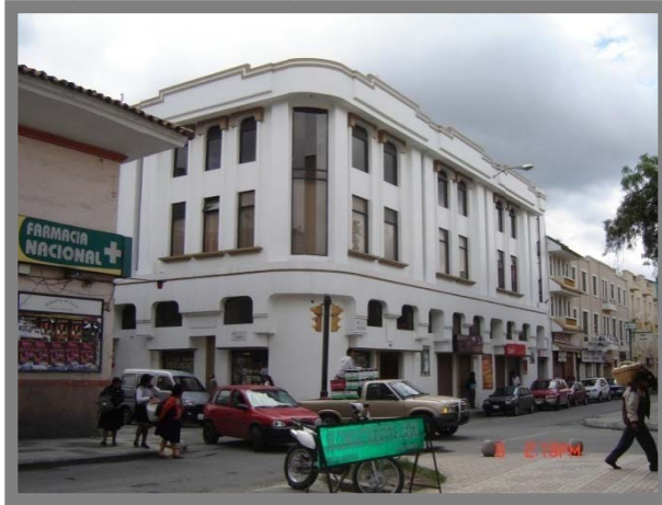
Foto 3.11 Edificación Nueva (antes edif. Patrimonial)
