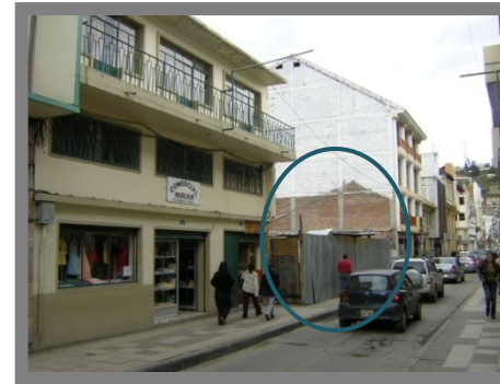
Foto 3.7 Construcción de edificación nueva Fuente: Plan de desarrollo urbano de la ciudad de Loja (2005- 2007)
