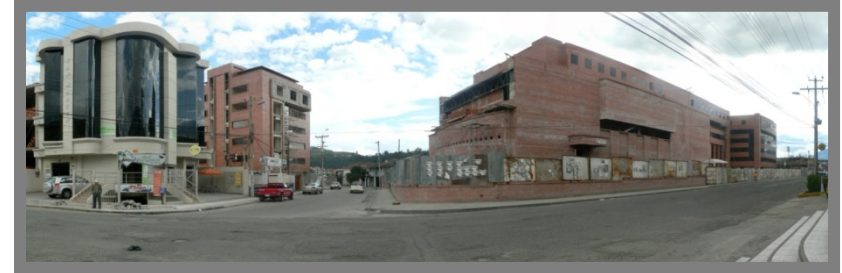
Foto 2.28 Alteración del entorno construido en el sector de El Ejido. Fuente: INPC (Dic. 2008)
