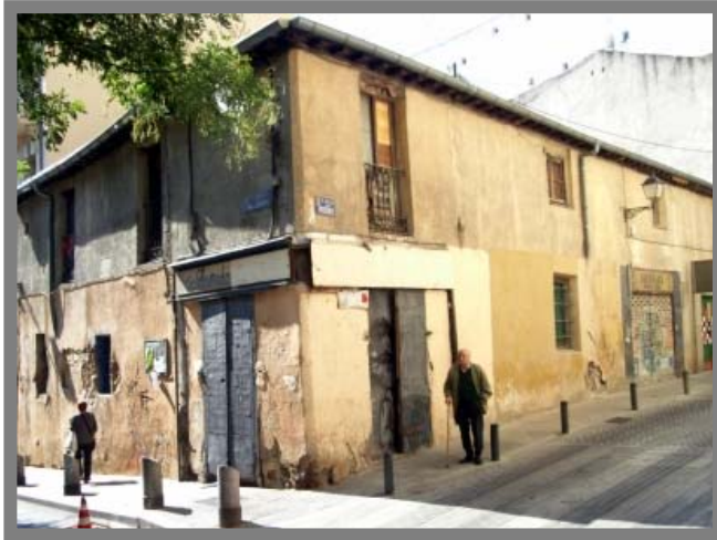
Foto 1.5 Edificio en estado de abandono, amenazando ruina, (Madrid) Fuente: www.urbancidades.wordpress.com/
