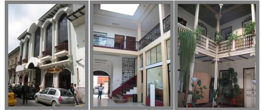
Foto. 3.22 Edificación nueva Foto. 3.23 Renovación Foto. 3.24 Restauración Fuente: Centro Histórico -IML Fuente: Centro Histórico -IML Fuente: Centro Histórico
