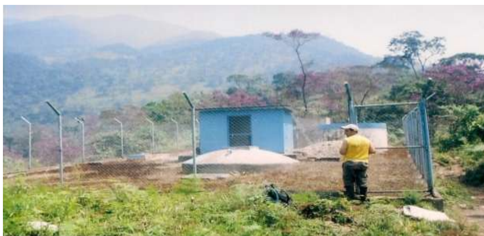
Planta de tratamiento Tutupali
