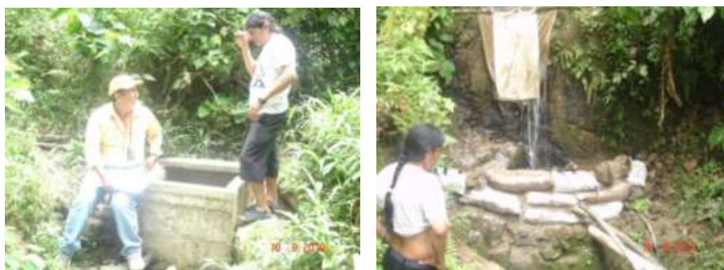
Captación No. 3 y cajón recolector
