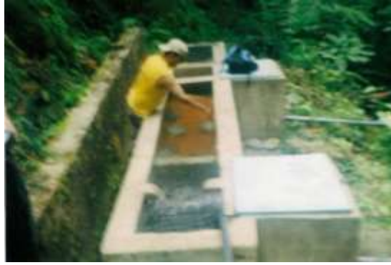
Desarenador, Tanque de entrada quebrada "El Retiro" y potreros junto a las riveras de las vertientes de agua.
