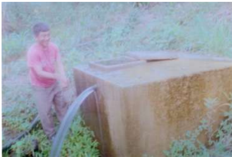
Tanque recolector y a la vez de distribución en buen estado sin limpieza del sistema de agua de Napurak.
