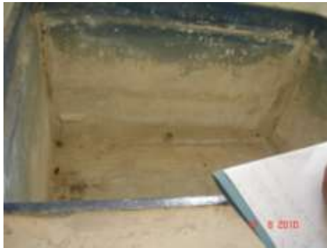
Caseta de cloración sin tanque ni dosificador de cloro en PT. La Paz
