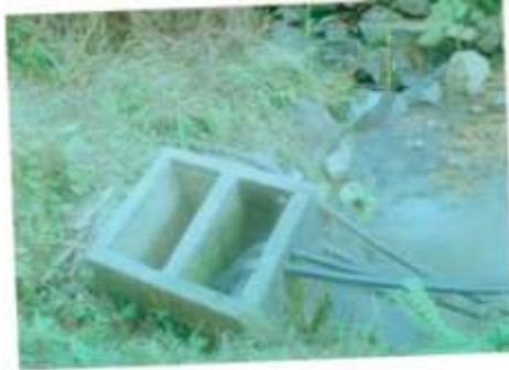
Captación construida en el caudal principal de la quebrada de Napurak
