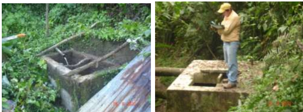
Captación No. 1 y No.2 del sistema de agua Potable La Paz
