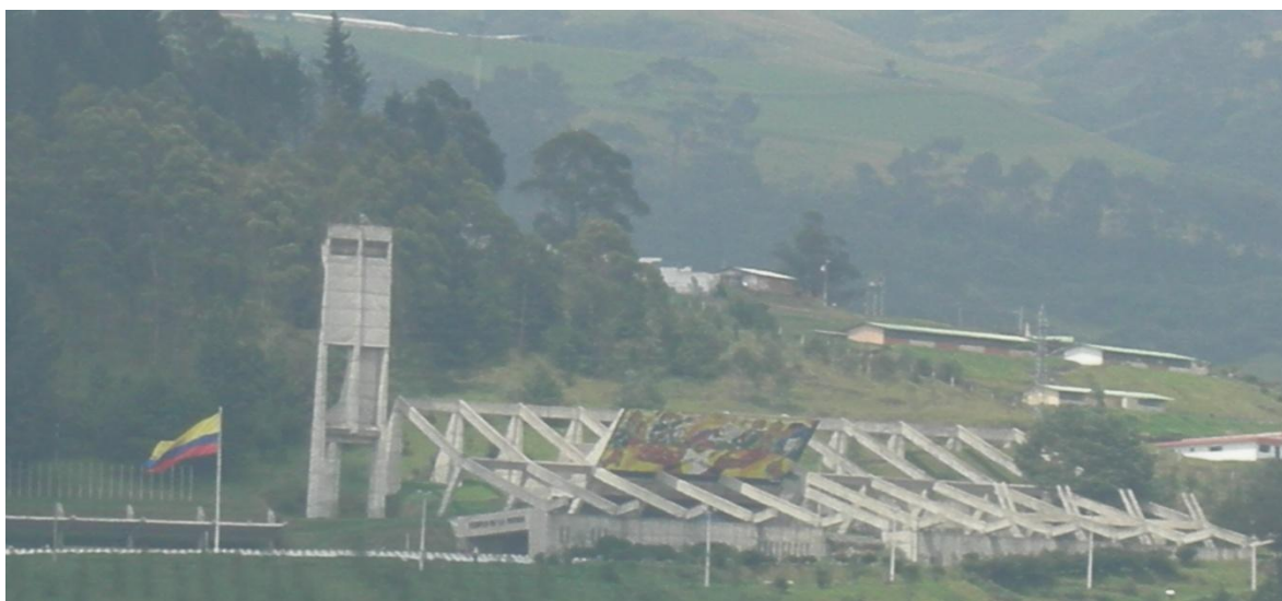
TEMPLO DE LA PATRIA, Y SUBCENTRO DE SALUD LA LIBERTAD UBICADO DETRÁS DE ESTA INSTITUCIÓN.
