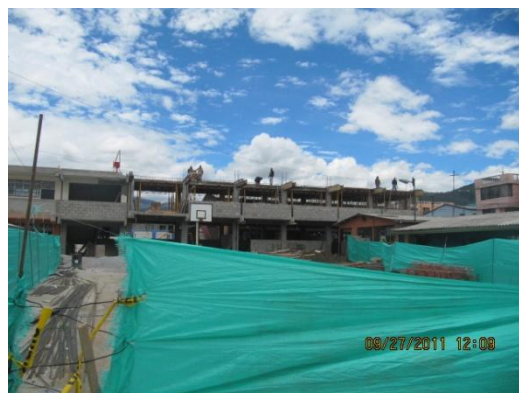
Nueva construcción para aulas
