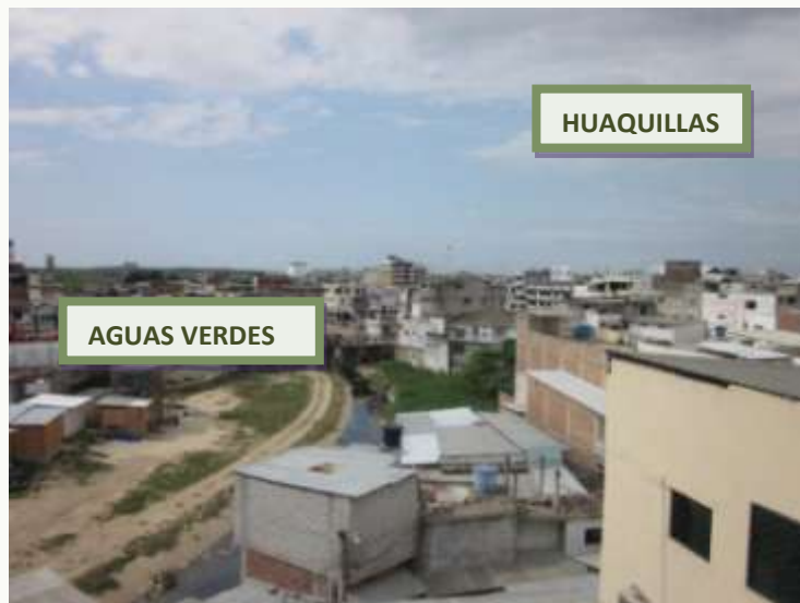
Foto #66. Canal Internacional Vista Panorámica (ACTUALIDAD).
