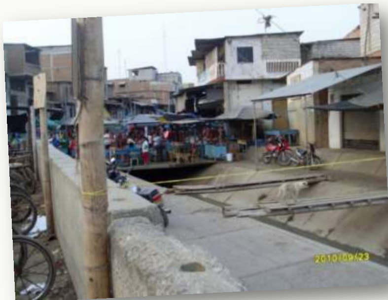
Foto # 51. Canal internacional. Fuente: elaborado por el autor.
