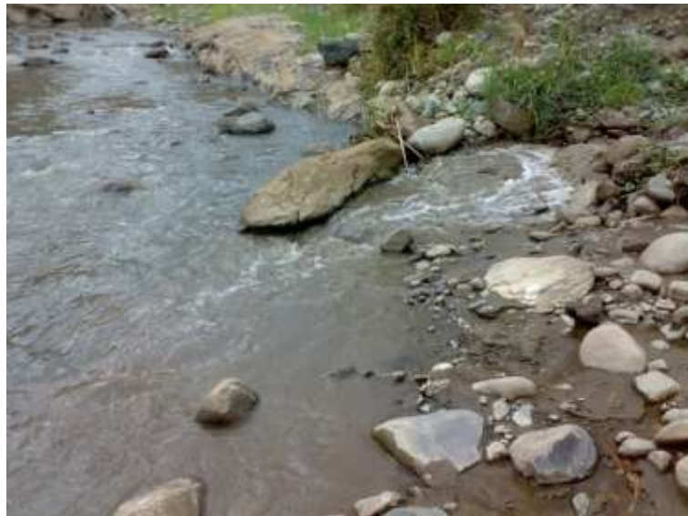
Foto 11: Descarga de aguas negras en el río Guayabal
