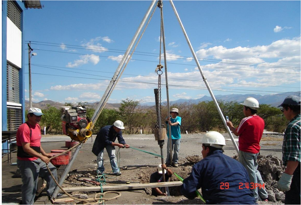
Foto N°. 5.2 Ensayo SPT pozo N°. 1
