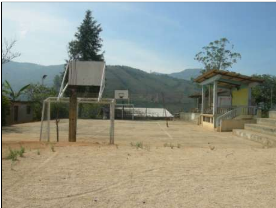
Cancha deportiva de Amarillos
