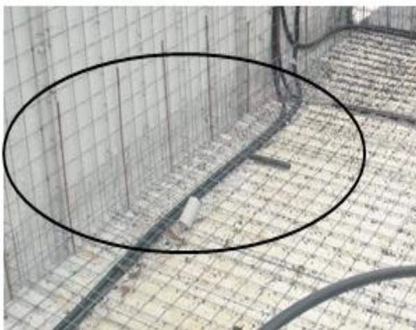
Fig. 2.10 Unión de losa con panel a través de chicotes. Conjunto habitacional "Las Ramblas". Fuente: El Autor.
