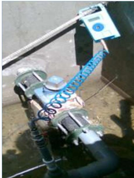
**Imagen 2.3.** Instalación de data logger
