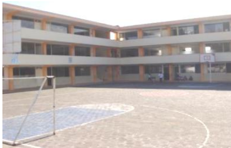
Instalaciones de la Unidad Educativa Municipal
