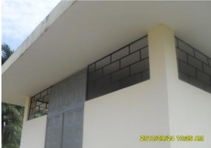
Foto 13. Caseta de disposición en el hospital Básico Zumba.
