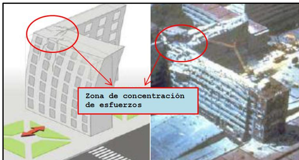
Figura 1.2 Falla producida por asimetría del edificio en planta (Fenómeno de Aleteo)
