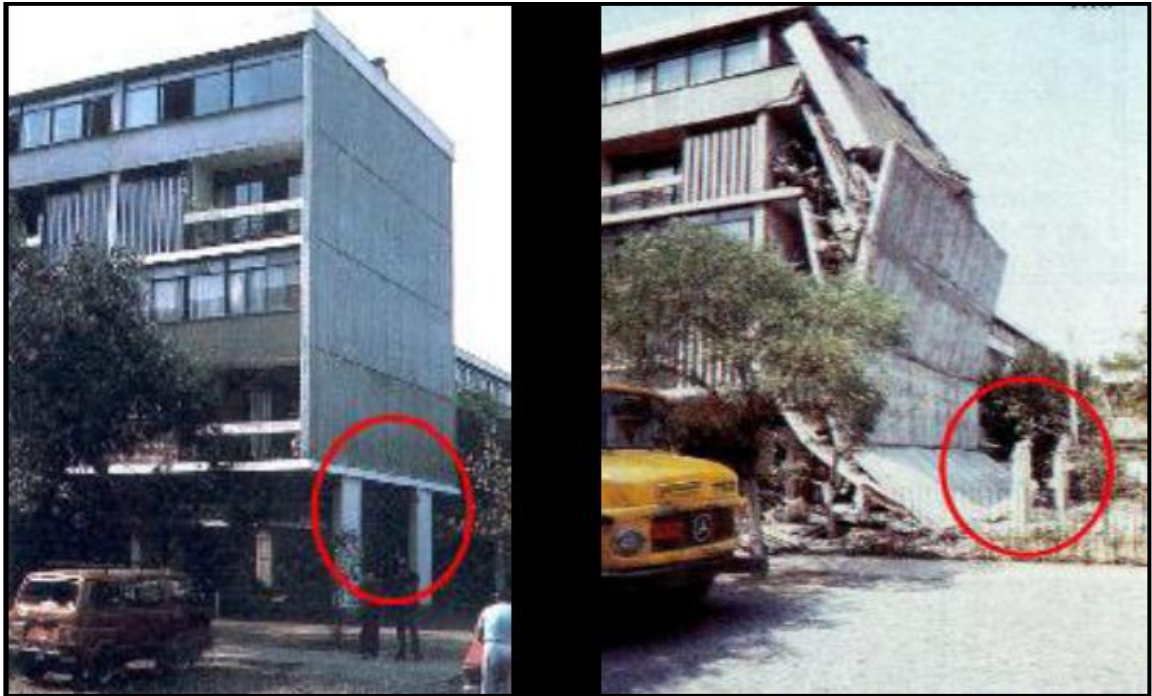
Figura 1.9 Colapso por discontinuidad de elementos estructurales verticales
