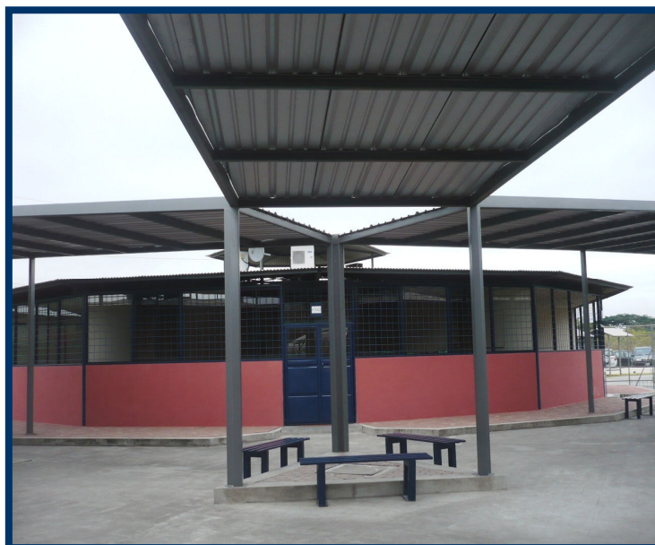
Espacios de descanso a los exteriores de las aulas
