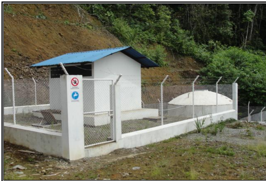
Figura N° 2: Planta de tratamiento de agua potable
