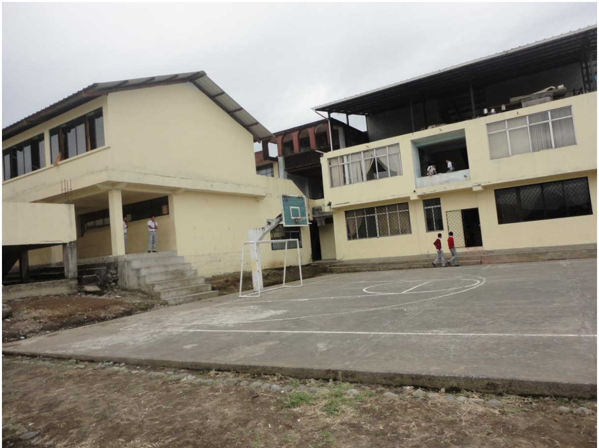
Foto 5: Vista parcial del bloque administrativo y de las aulas
