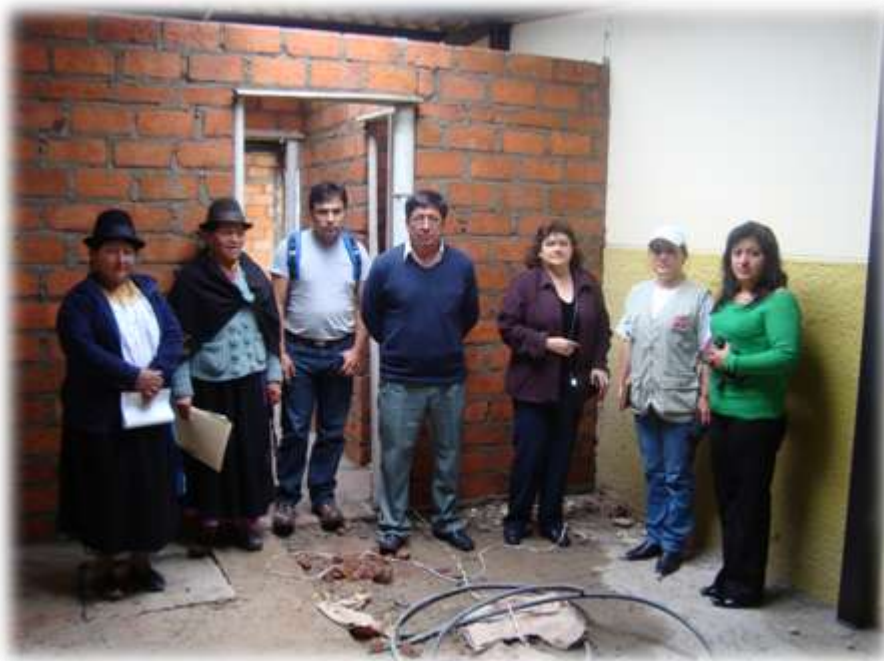
Se inicia la construcción de la Sala de parto
