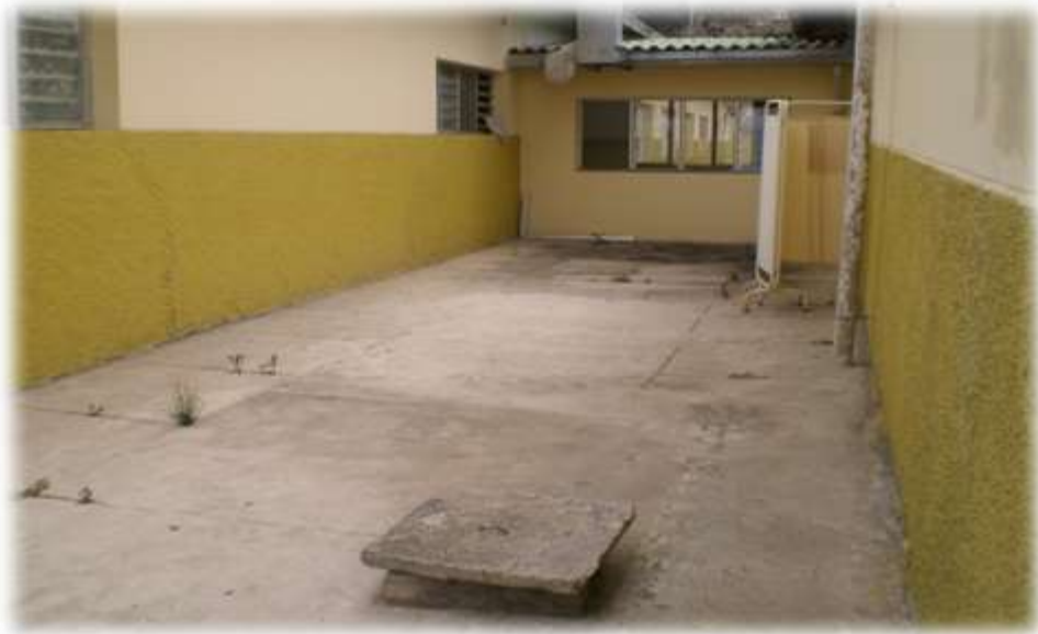
Area física donde se construirá la sala de parto culturalmente adecuado.
