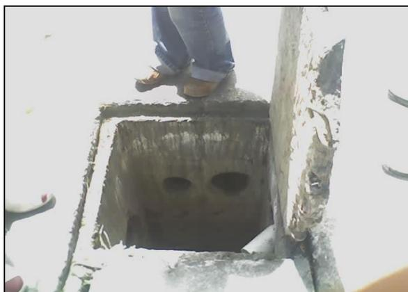
Se puede ver en la caja de revisión las condiciones en la que se encuentran las tuberías en este caso están en buenas condiciones.
