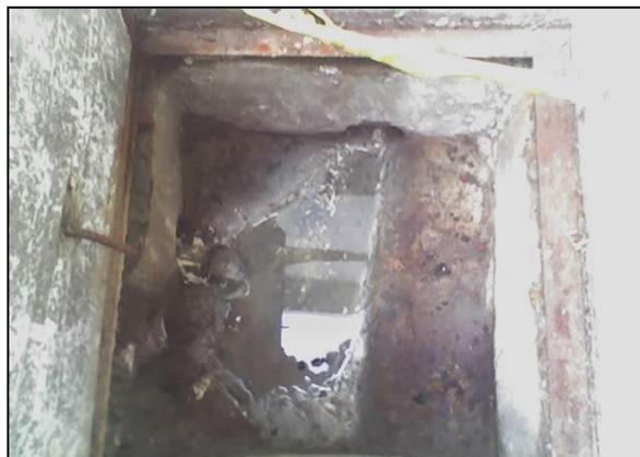
En la fotografía 1 y 2 se puede apreciar que las cajas de revisión el agua residual se encuentra estancada y tiene una correcta evacuación, la condición es la que se encuentra en las cajas de revisión.
