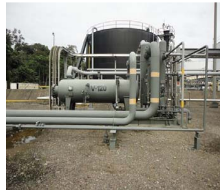
Fotografía 14: Domo de Gas
