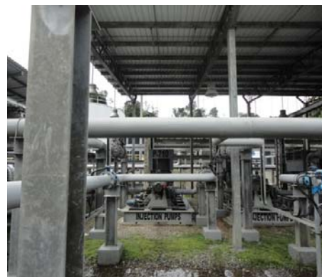
Fotografía 8: Bombas de inyección de agua
