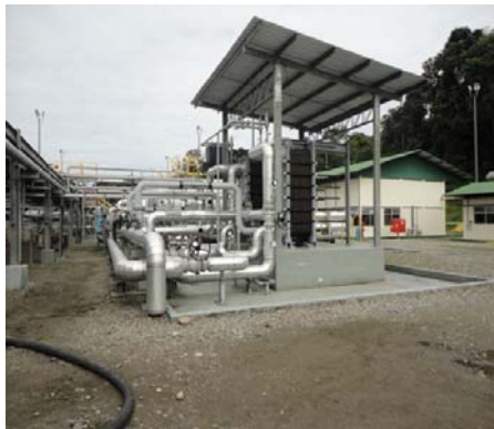
Fotografía 3: Intercambiadores de calor
