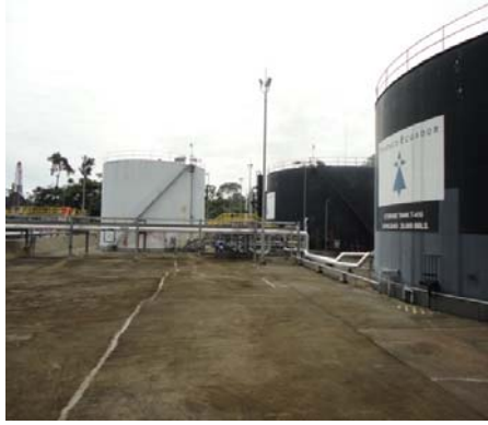
Fotografía 1: Área de tanques
