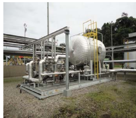
Fotografía 16: Tanque recolector de Aceite Térmico
