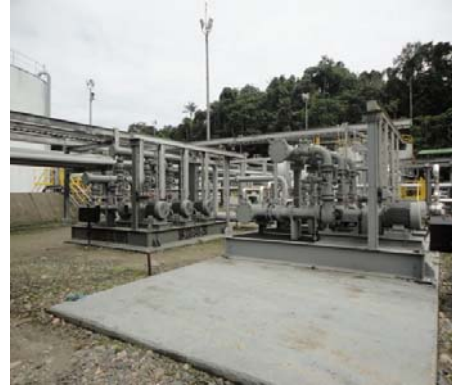
Fotografía 2: Bombas de trasferencia
