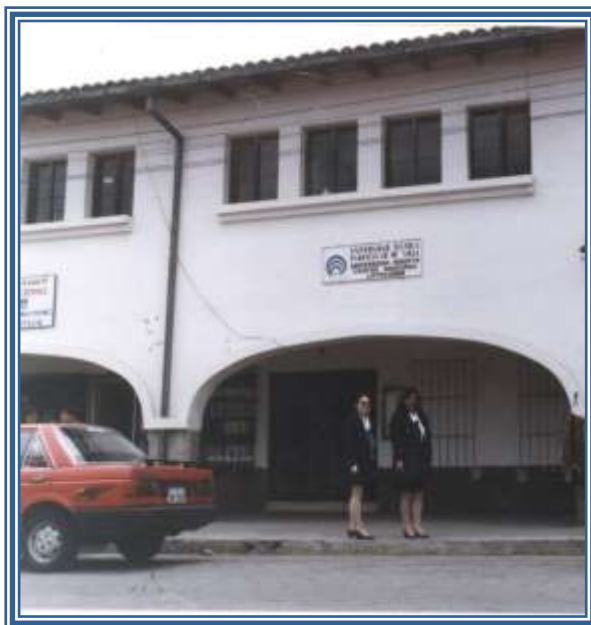
FOTO 6: Oficinas del Centro Asociado ubicadas en los bajos de San Agustín FUENTE: Lic. Douglas Álvarez
